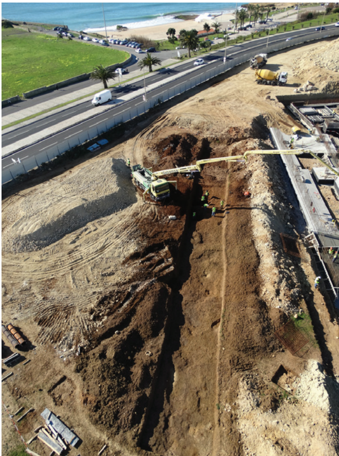
Figura 2 – Vista geral da “Vala 12”.
