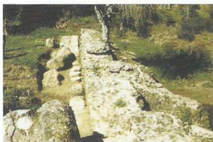
Figura 19.34 Barragem romana do Pego da Moura. Vista de jusante.
