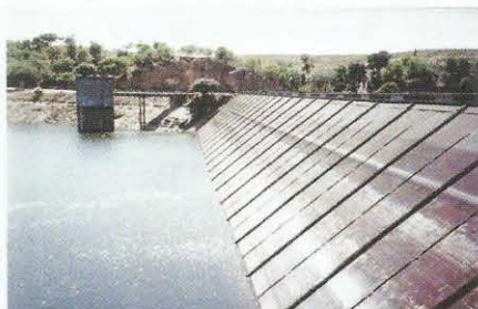
Figura 19.22 Barragem do Pego do Altar. Vista de montante, notando-se a cortina de impermeabilização e a torre da tomada de água.
