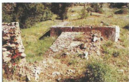
Figura 19.7 Moinho do Pisão. Muro da casa do moinho (à esquerda), rampa de alvenaria integrando as duas cales e muros da caldeira.
