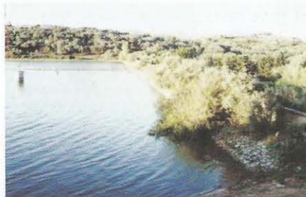
Figura 19.19 Barragem da Serra. Vista de montante, notando-se o enrocamento de protecção do paramento e a tomada de água.
