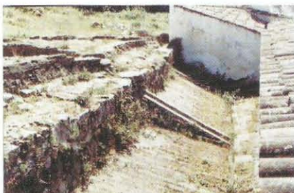
Figura 19.6 Moinho da Mitra. Muro da caldeira e cales abertas.
