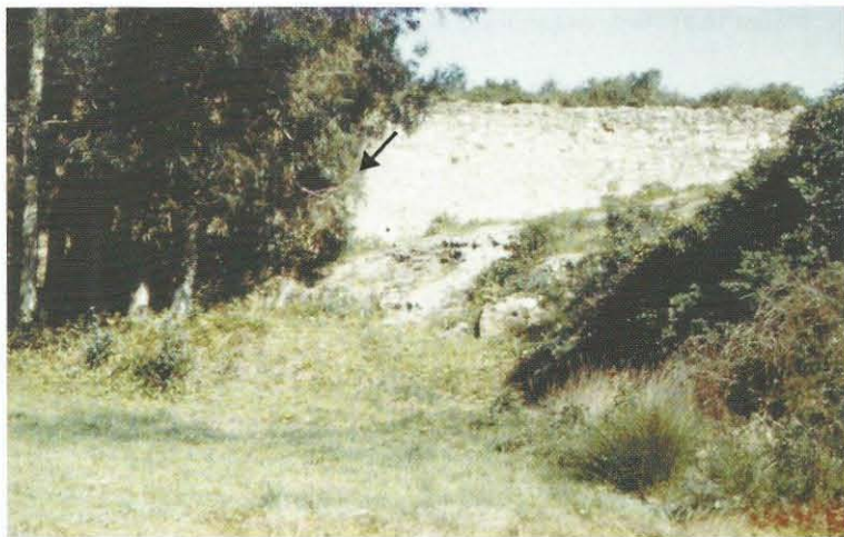
Figura 19.37 Barragem da Mandorelha I. Vista de montante, notando-se a descarga de fundo (assinalada por seta).
