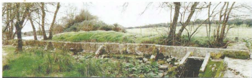
Figura 19.12 Moinho Novo (ribeira das Alcáçovas). Trecho inicial da levada, com descarga lateral para controlo do caudal.
