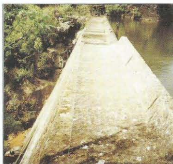
Figura 19.23 Barragem de Jungeis. Vista do coroamento, notando-se o comando de uma comporta – ensecadeira e o descarregador de superfície (com o coroamento a menor cota).
