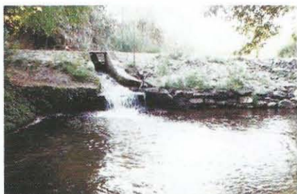
Figura 19.5 Açude do moinho das Falés, vista de jusante, notando-se a descarga de meio fundo.
