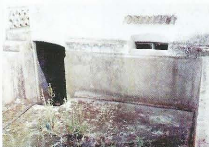
Figura 19.28 Engenho de descasque de arroz da Herdade de Porches. Zona de jusante da câmara de carga, notando-se o vão de entrada para a câmara da turbina.
