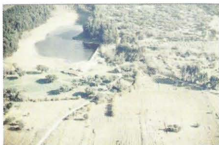
Figura 19.16 Barragem da Defesa das Cortiçadas. Vista aérea.
