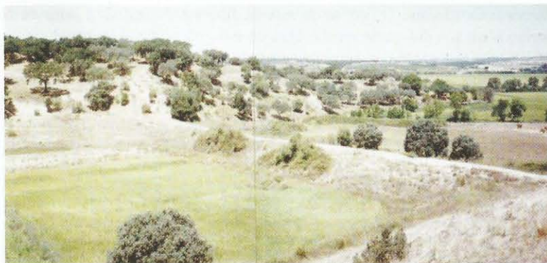
Figura 19.24 Barragem da Torre I. Vista de montante.
