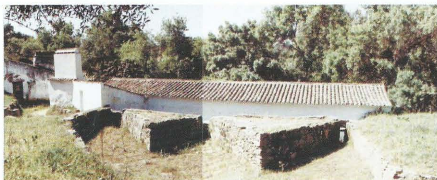
Figura 19.9 Moinho da Mitra. Caldeira com talhamares, notando-se as três entradas para as cales.
