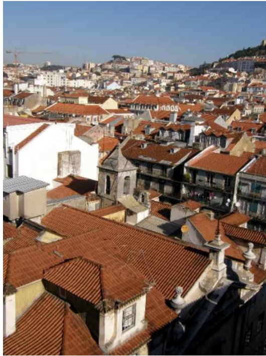
Fig.34 -Cobertura e Torre Sineira (FA)
