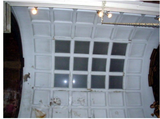
Fig.42 -Cobertura/Capela Mor (FA)
