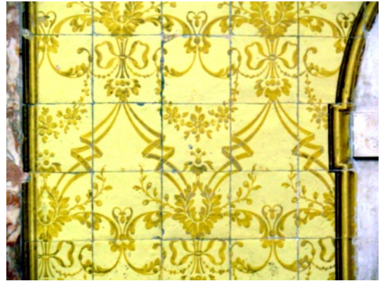
Fig.132 -Sacristia (tapete/parede) (FA)
