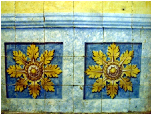
Fig.123 -Sacristia/corredor (por. rodapé) (F.A.)
