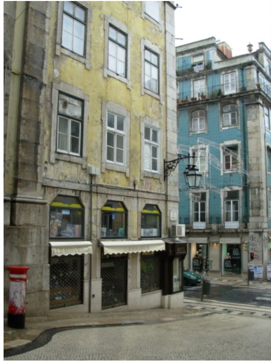
Fig.19 -Edifício da Irmandade e lojas (nascente) (FA)
