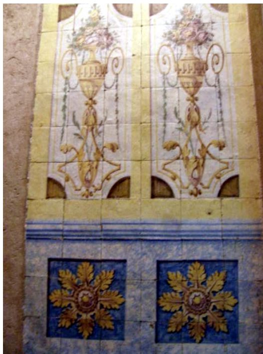
Fig.120 -Sacristia/corredor (rodapé) (FA)
