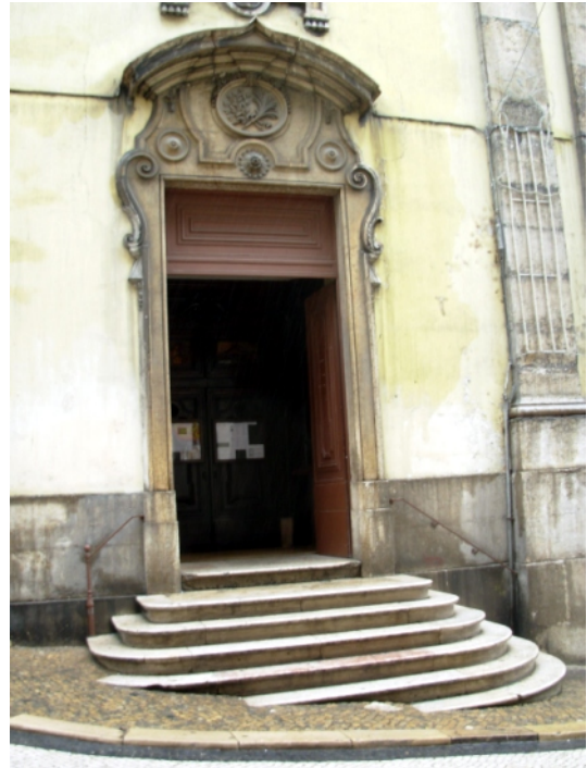
Fig.23- Portal e escadaria (FA)
