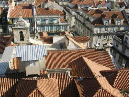
Fig.33 -Cobertura e Torre Sineira (FA)
