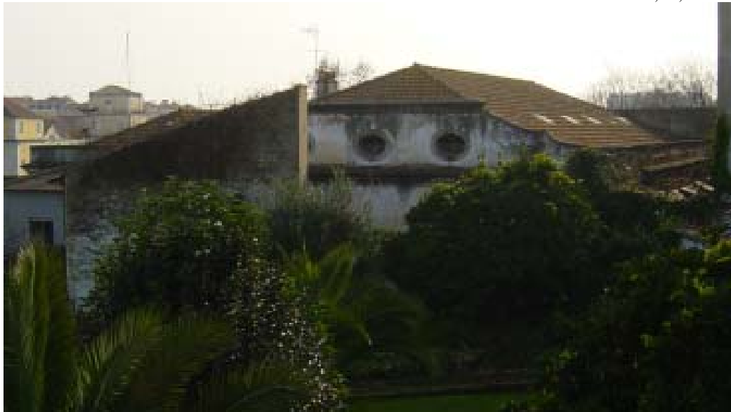
Figura 88 – Construção existente na actualidade e que serve de garagem associada a uma bomba de gasolina situada na Rua Domingos Sequeira.
