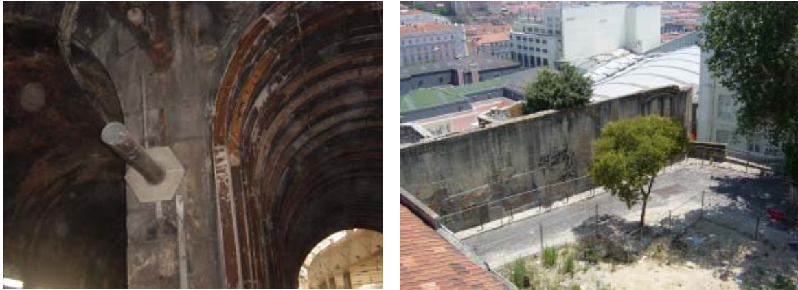
Figuras 41 e 42 – Túnel do Rossio, precisamente sob a Calçada da Glória, e provável localização da cisterna junto ao Largo da Oliveirinha, sob o prédio em ruínas, vendo-se ao fundo a cobertura da saída do túnel.
