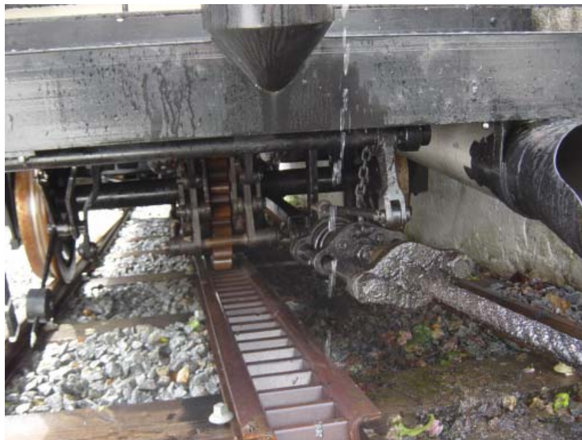
Figura 8 – Ascensor do Bom Jesus do Monte, em Braga. Em primeiro plano o cabo e a cremalheira Riggenbach, vendo-se a roda dentada no mesmo eixo das rodas de direcção.
