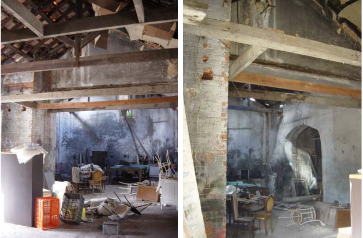
Figuras 25 e 26 – O interior da caza da machina , visto do barracão, com a chaminé à esquerda.
