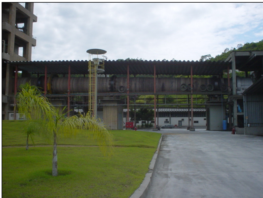
Figura 1.2.6. Foto da Vista Lateral do Forno Rotativo. Fonte: Cimenteira Estudada, 2013.
