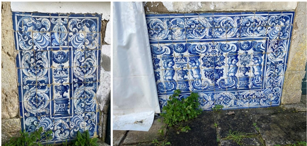
Fig. 96 e 97 - Pormenores da albarrada de azulejos azuis e brancos no exterior da Capela de São José, datável do século XVIII.
