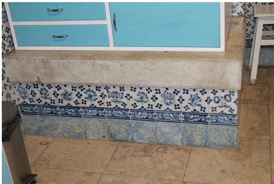
Fig. 210 – Pormenor do rodapé do revestimento cerâmico da cozinha da Vivenda Sol e Serra. Fotografia: CMVFX.
