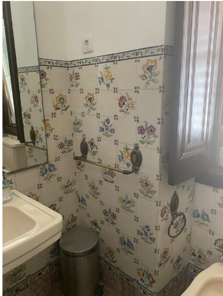
Fig. 211 – Silhar cerâmico policromo da casa de banho da Vivenda Sol e Serra
