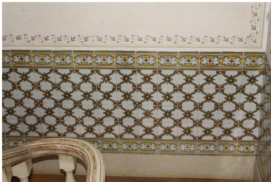
Fig. 65 - Silhar de azulejos com padrão pombalino. Fotografia: CMVFX.
