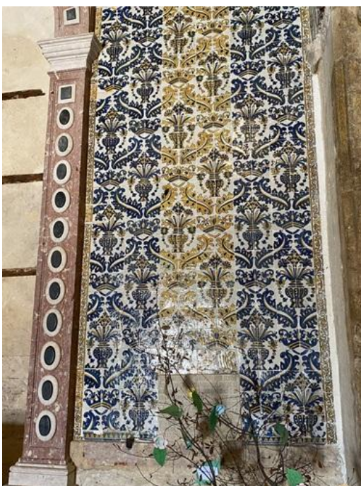
Fig. 85 - Padrão de azulejos da Igreja do antigo Convento de Almoster
