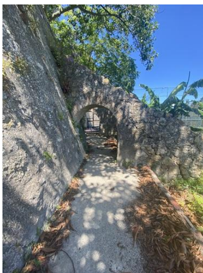
Fig. 39 – Contraforte do muro que ladeia o caminho para a casa de fresco.
