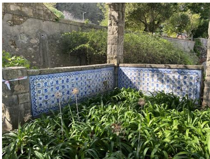
Fig. 29 – Vista de muretes e do muro de suporte.
