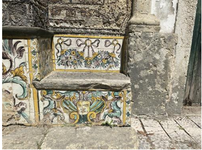
Fig. 153 - Painéis de azulejos da secção 3, níveis 1 e 2.
