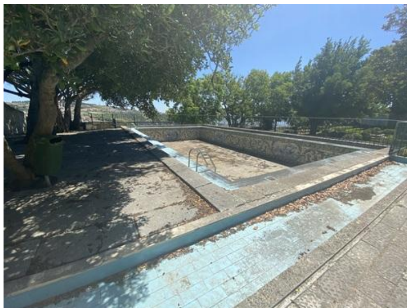
Fig. 36 - Vista geral do antigo tanque de rega adaptado a piscina.
