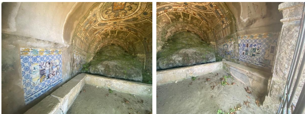
Fig. 170 e 171 – Vistas dos painéis de azulejos da casa de fresco.
