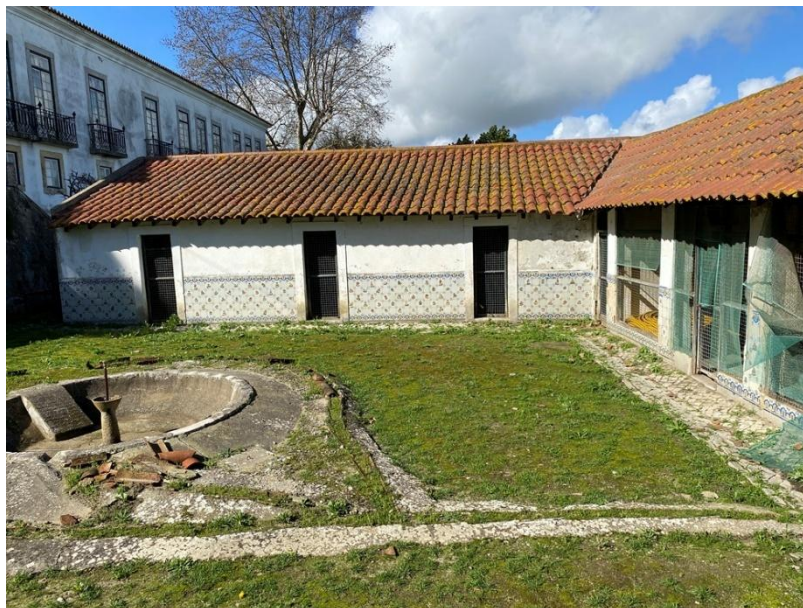
Fig. 227 – Abegoaria, fotografia tirada no dia 15-02-2024 (antes das obras).
