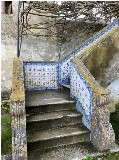
Fig. 136 – Escada em “L” com azulejos de figura avulsa azuis e brancos.
