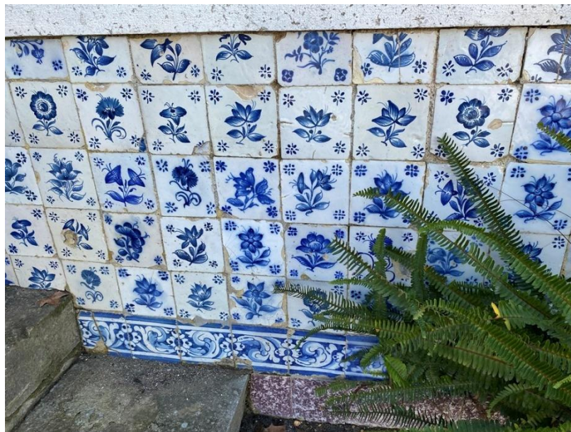
Fig. 219 – Pormenor do revestimento exterior do escritório.
