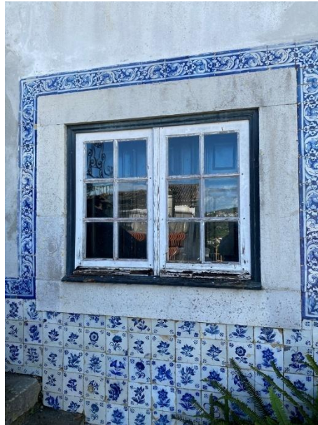
Fig. 218 – Pormenor do revestimento exterior do escritório.
