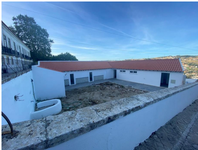
Fig. 228 – Abegoaria, fotografia tirada no dia 13-09-2025 (após as obras).
