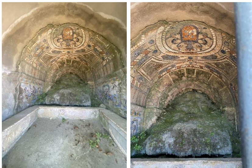
Fig. 59 e 60 – Casa de fresco vista geral e vista aproximada. 222
