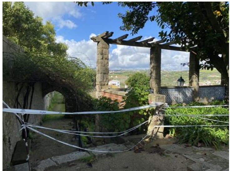
Fig. 137 – Vista do murete junto à escada que dá acesso à casa de fresco
