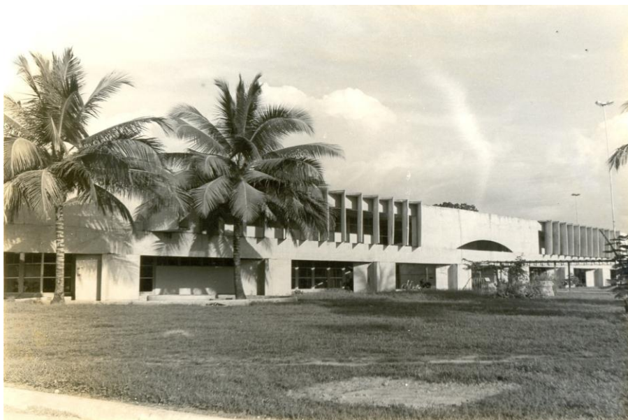
Figura 7 - Prédio da Biblioteca Central no ano de 2013
