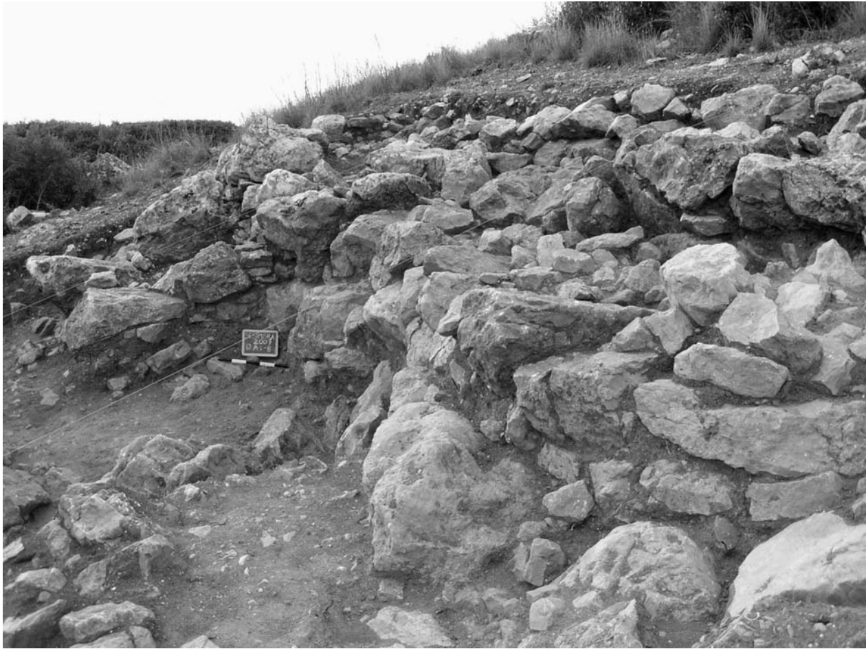
Fig. 6 – Outeiro Redondo. Vista parcial do dispositivo defensivo posto a descoberto do lado oriental do morro, onde o declive é maior, evidenciando-se a técnica construtiva de sucessivos muros adossados longitudinalmente, para, pelo peso, garantirem a estabilidade do terrapleno superior. Foto J. L. Cardoso.
