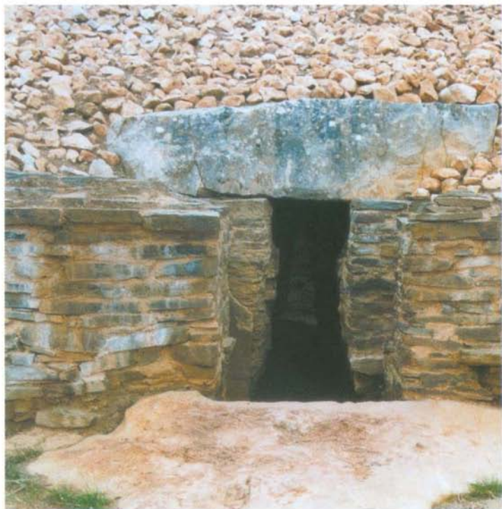
xxxii Vista da entrada da tholos n.º 7 de Alcalar (Portimão), após as obras de recuperação recentemente ali realizadas pelo IPPAR, sob a orientação de Rui Parreira (foto de J. L. Cardoso).
