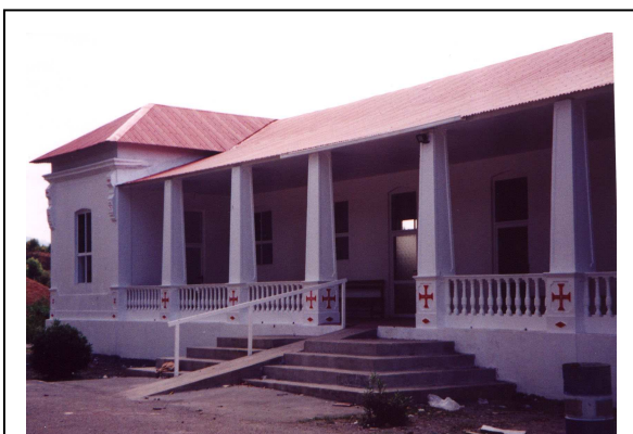
Figura 6 Hospital de Liquiçá
