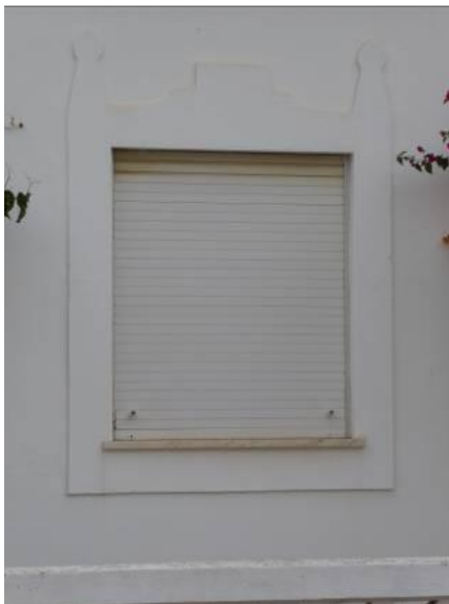
Figura 69 – Tipo original de moldura de janela (excepto persianas) (2008). Foto do autor.
