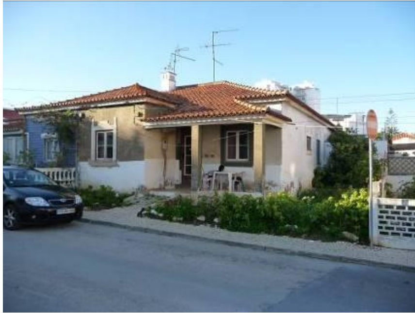
Figura 53 – O n.º 2 da Rua Dr. Manuel de Andrade. Outro caso em que se manteve a traça original (2008). Foto do autor.
