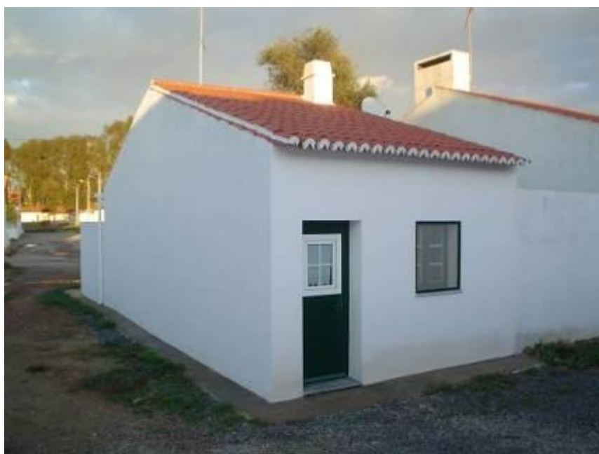
Figura 32 – Minas de S. Domingos. Pequena casa, (2008) Foto do autor.
