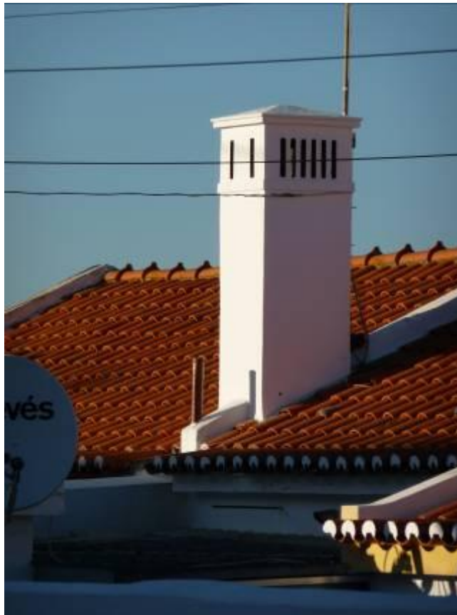
Figura 72 – Chaminé original (2008). Foto do autor.
