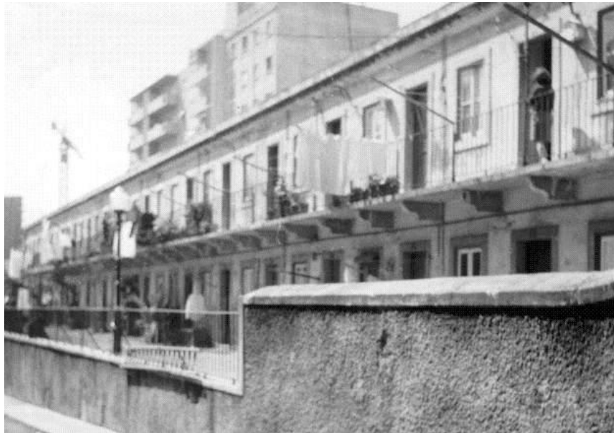
Figura 13 – Pátio Bagatela, na Travessa da Légua da Póvoa, São Mamede, Lisboa, constituído por um grande bloco de dois pisos com galeria tipo vila e pátio sobreelevado em relação à rua. Autor: João H. Goulard, (1968). Imagem: AF\img130\A64552.jpg. Código de referência: PT/AMLSB/JHG/S02401. Em Arquivo Municipal de Lisboa/Arquivos Fotográfico/João Hermes Goulard.
