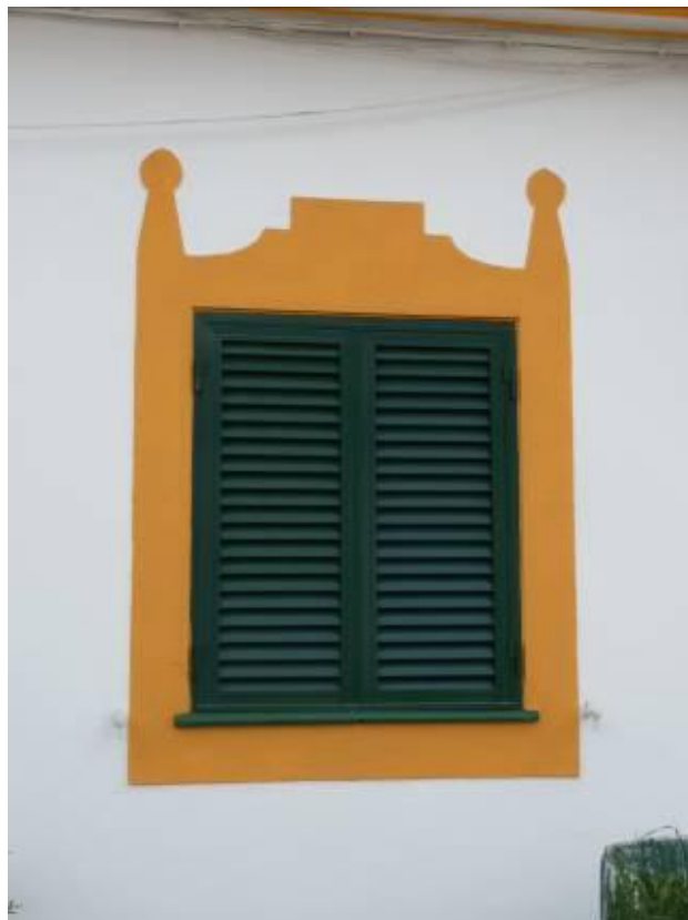
Figura 68 – Tipo original de moldura de janela (excepto portadas) (2008). Foto do autor.
