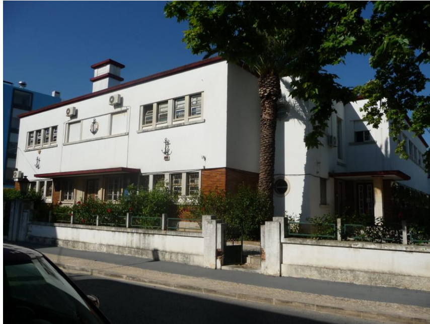
Figura 81 – Vista Poente/Sul da Casa dos Pescadores de Portimão (2010). Foto do autor.
