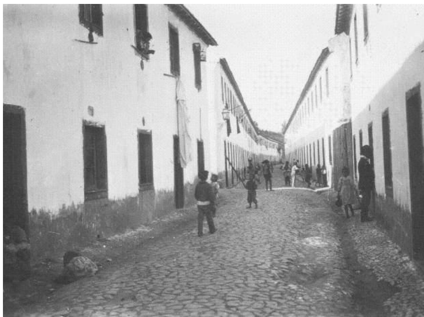
Figura 15 - Arco da Vila Dias, na Rua Alves Paiva Fragoso, no Beato, Lisboa. Na imagem visualizamos uma das tipologias utilizadas, com a criação de uma rua particular de grande extensão. Autor: Carlos Alberto Lima (Início do séc. XX). Imagem: AF\img29\A14408.jpg. Código de referência: PT/AMLSB/AF/LIM/000884. Autor: Alberto Carlos Lima (s.d.). Em ,Arquivo Municipal de Lisboa/Arquivos Fotográfico/Alberto Carlos Lima.
