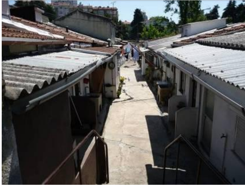
Figura 25 – Corredor de acesso à ilha da Fábrica das Fechaduras, Bairro da Póvoa, Porto. Esta ilha foi construída de raiz para esta unidade fabril, (2009). Foto do autor.
