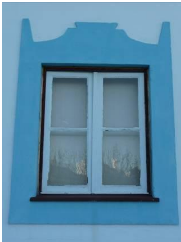
Figura 66 – Janela original (2008). Foto do autor.
