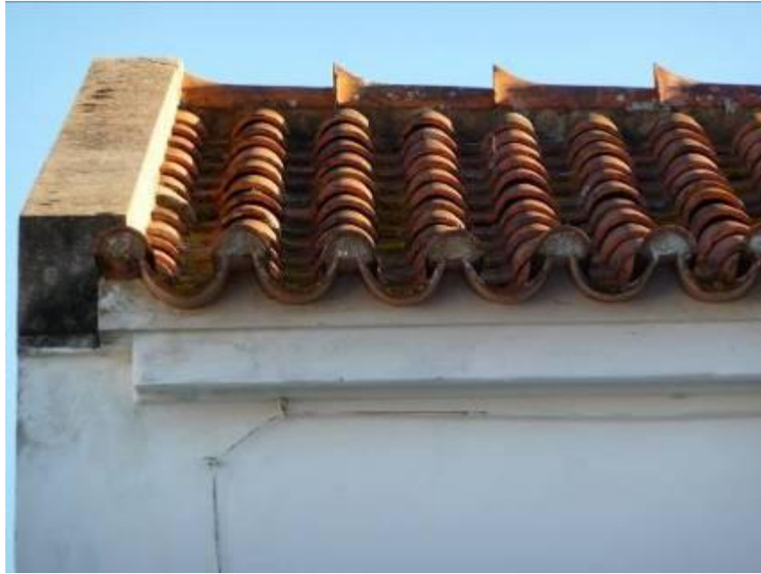
Figura 73 – Beirado de telhado original (2008). Foto do autor.
