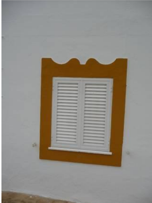
Figura 67– Tipo original de moldura de janela (excepto portadas) (2008). Foto do autor.
