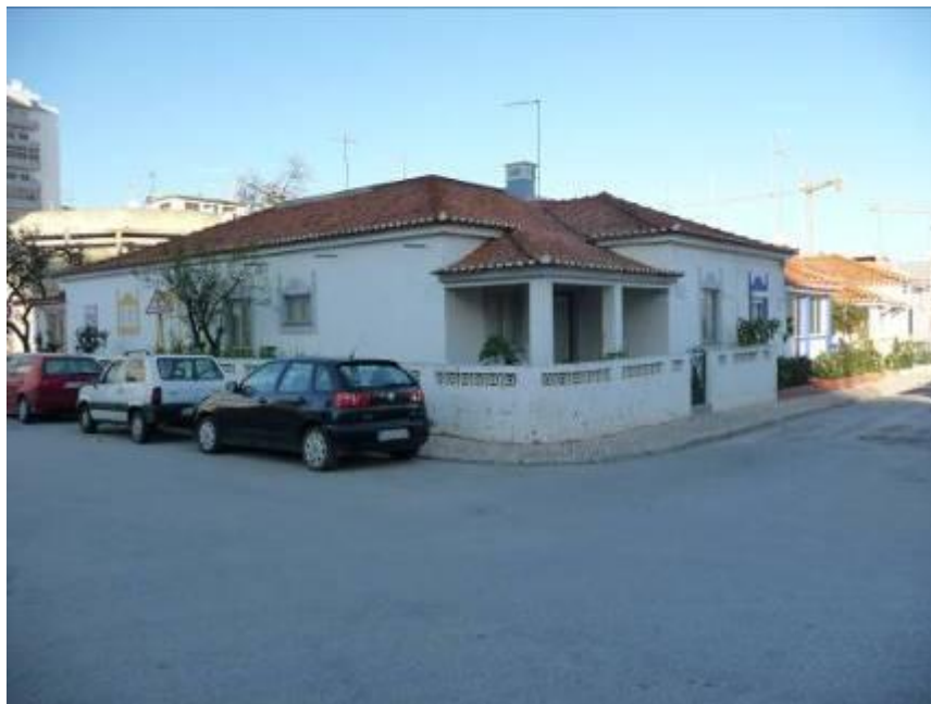
Figura 58 – O n.º 16 da Rua Eng. Sebastião Ramirez (2008). Foto do autor.
