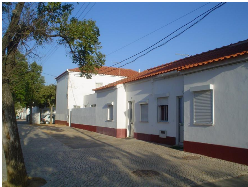
Figura 84 – Fachadas de habitações do Bairro do Pontal, construídas para famílias pobres nos anos 30 do século XX (2006). Foto do autor.
