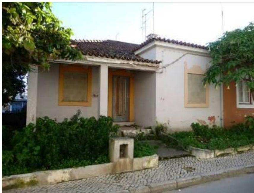
Figura 52 – O n.º 3 da Rua dos Operários Conserveiros, presentemente devoluta. Uma das que mantêm a traça original (2008). Foto do autor.
