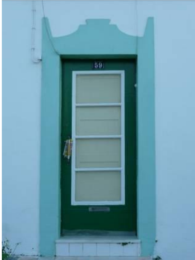
Figura 65 – Porta original, (excepto ferragens) (2008). Foto do autor.
