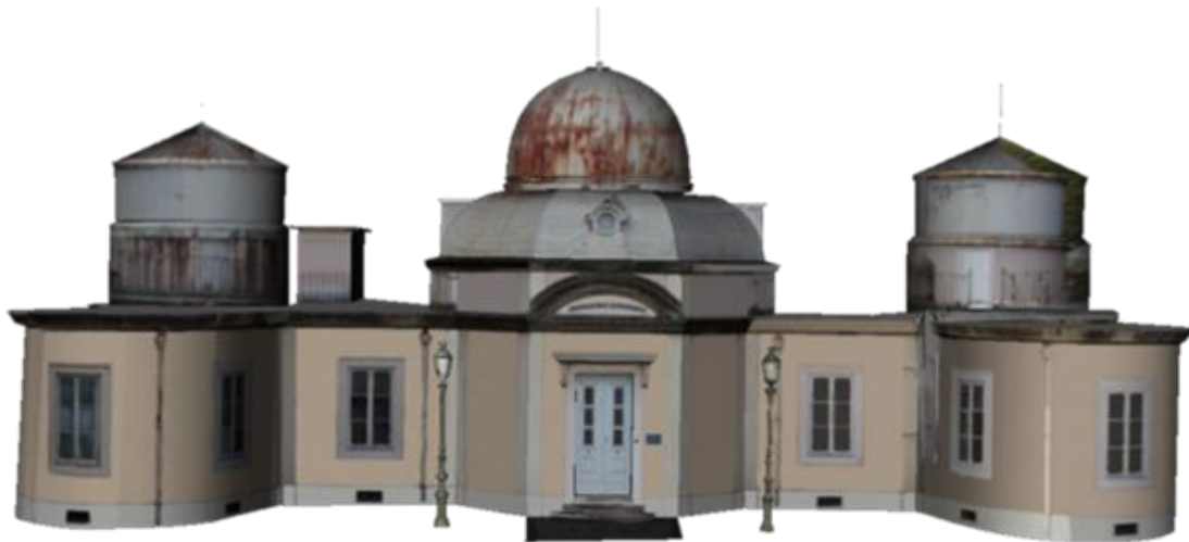
Figura 4 – Vista da fachada principal do modelo 3D fotogramétrico.
