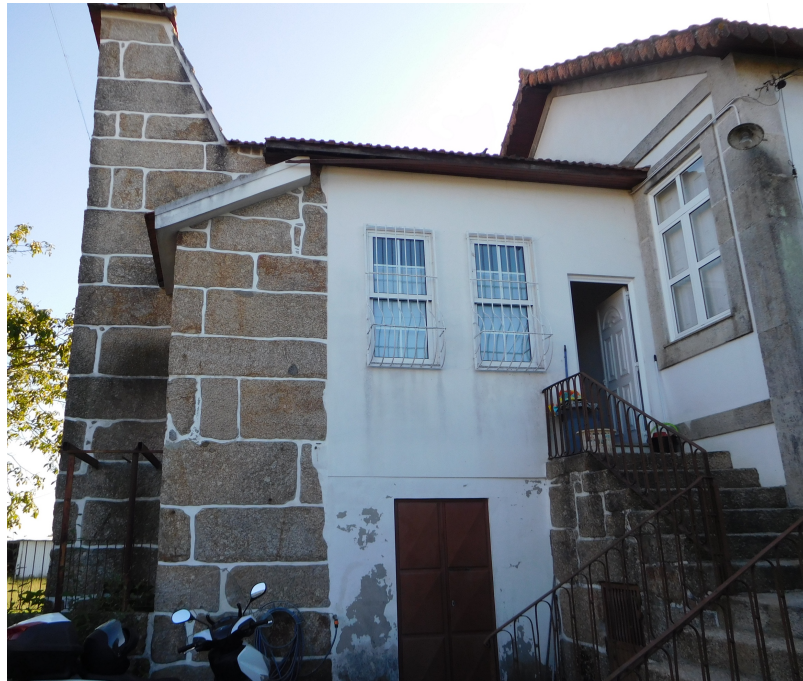
Figura 4.2-IV. Entrada de Serviço
