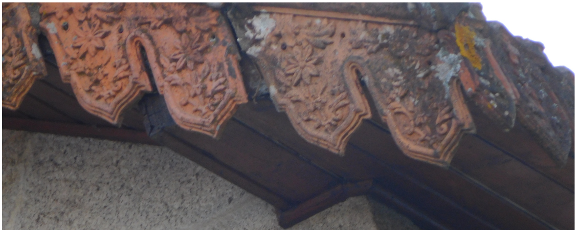
Figura 4.2-V. Remate do telhado
