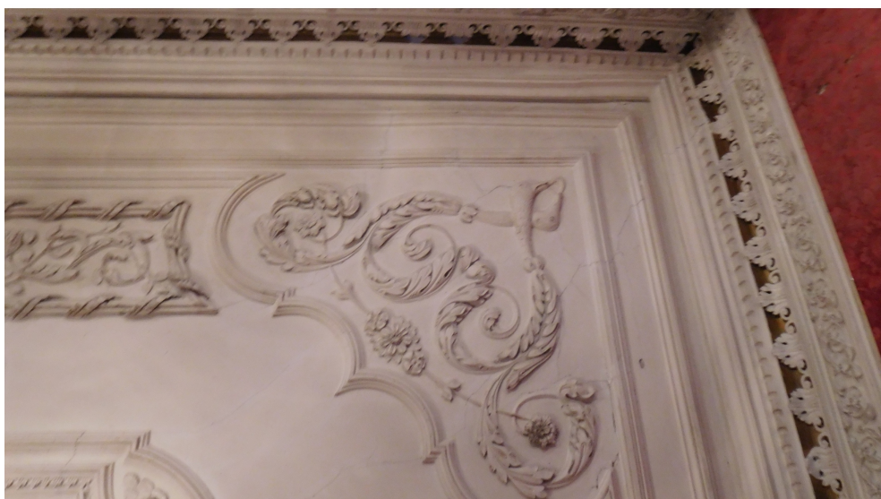
Figura 2.2-XI. Teto da sala de estar
