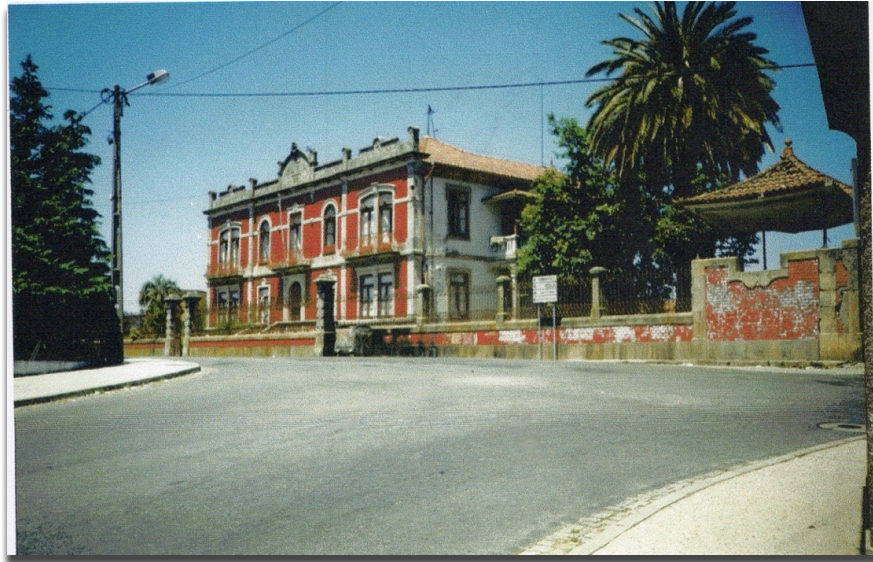
Figura 6.2-I. Fachada principal (A. B. M.P.F)
