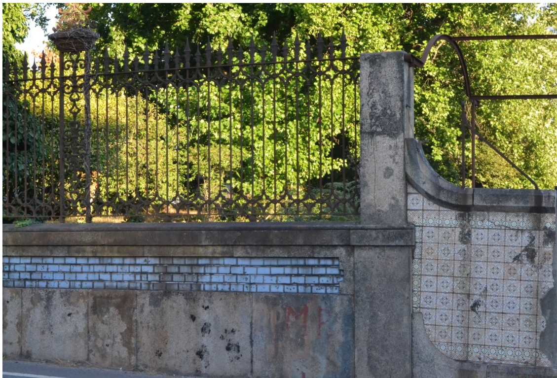
Figura 5.2-VIII. Muro de vedação
