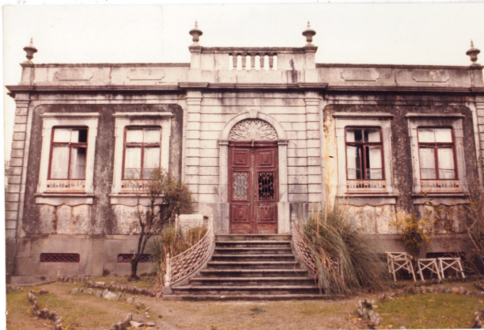
Figura 7.2-I. Casa em ruínas (A.B.M.P.F)
