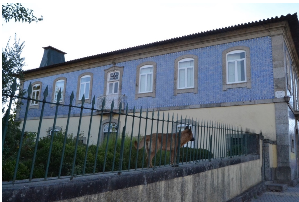
Figura 1.2-II. Alçado Principal/ janelas remodeladas
