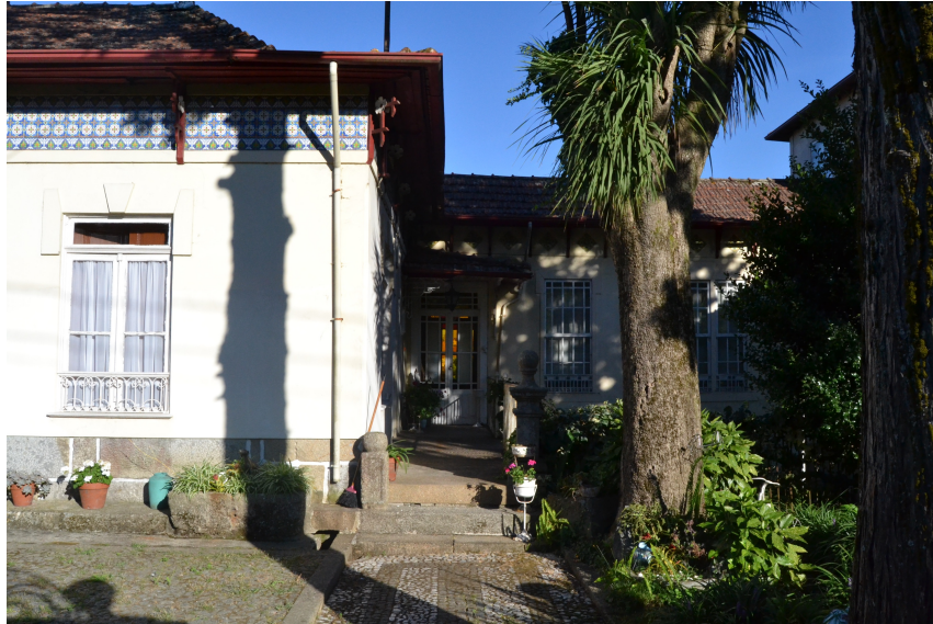
Figura 2.2-V. Fachada principal segundo e terceiro corpo
