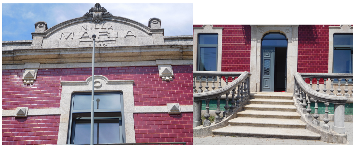
Figura 6.2-IX. Pormenores da fachada principal
