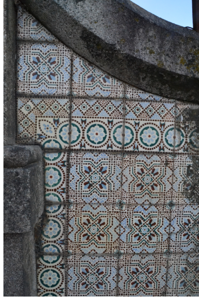
Figura 5.2-IX. Pormenor do muro da vedação
