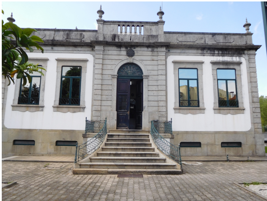
Figura 7.2-II. Fachada principal reabilitada
