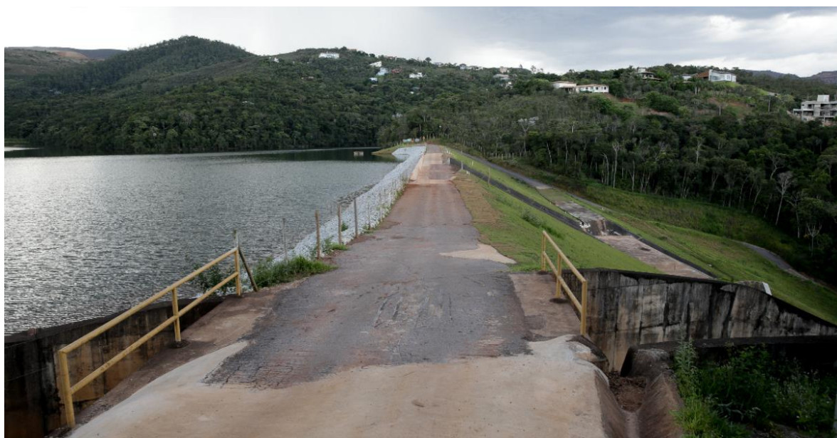
Figura 4:14 - Imagem da barragem B3/B4 da Mina Mar Azul, da Vale, em Macacos
