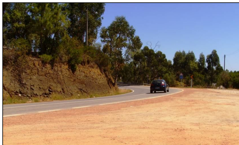
Aspecto da estrada
