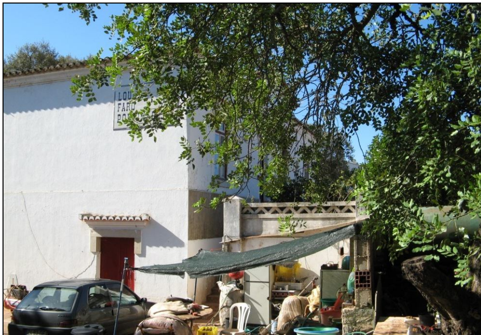
Fachada lateral: porta no piso inferior
