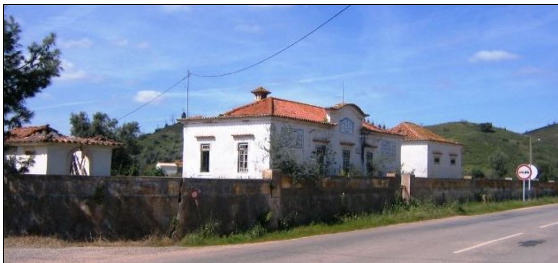
Conjunto - fachadas principal e lateral
