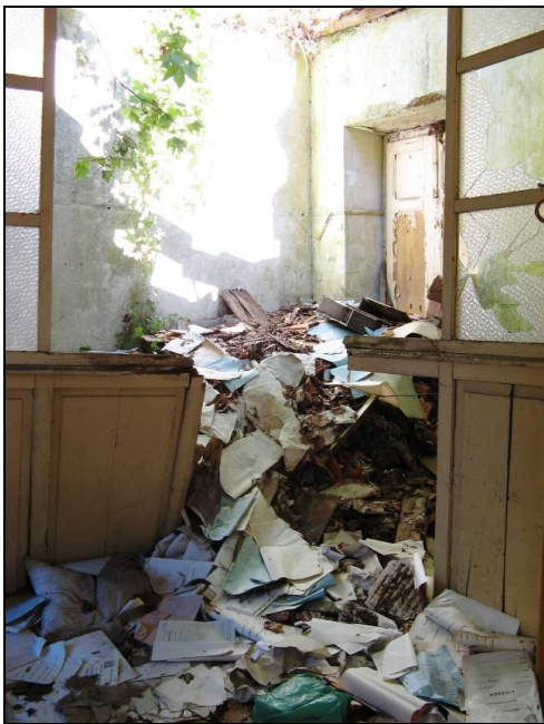
B- Pormenor do interior, distinguindo-se uma divisória em madeira e vidro
