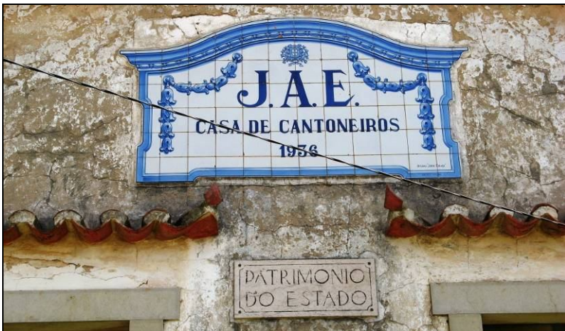
Painel de azulejo e placa de “Património do Estado”
