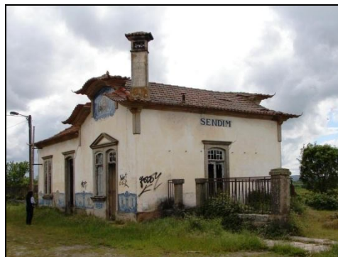
Estação de Sendim
