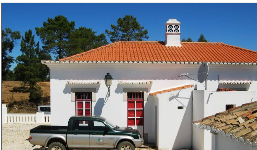
Aspecto da fachada posterior
