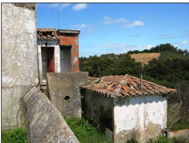
Vista das traseiras: arrecadação
