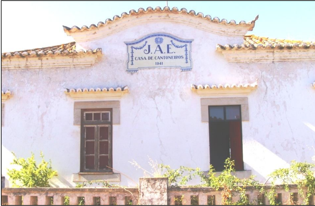
Caixilho de madeira e caixilho de alumínio
