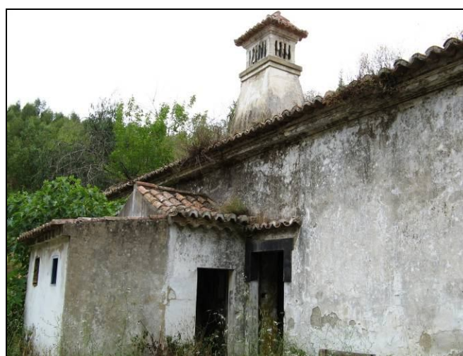
Aspecto da fachada posterior
