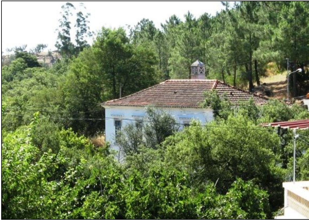
Vista da fachada posterior
