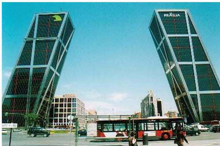
Figura 67: Um modelo poliédrico invulgar em edifícios: os prismas quadrangulares oblíquos das torres Kio, em Madrid, Espanha (inauguradas em 1996).
