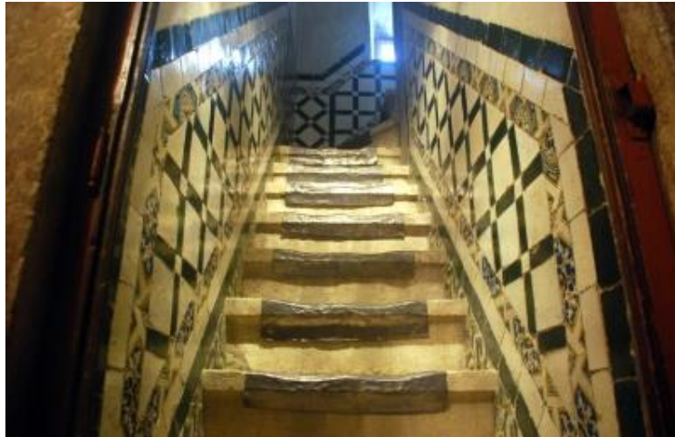
Fig. 29 molde de aço nas escadas de acesso ao coro alto
