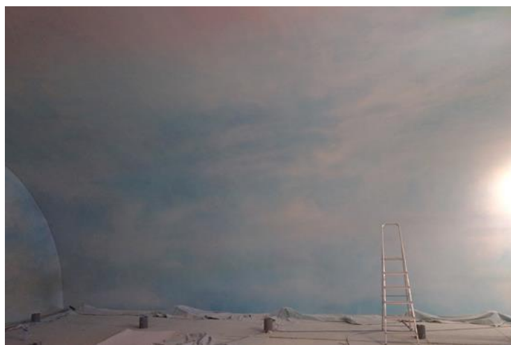
Fig. 16 Execução da pintura para o teto da igreja de Santa Isabel
