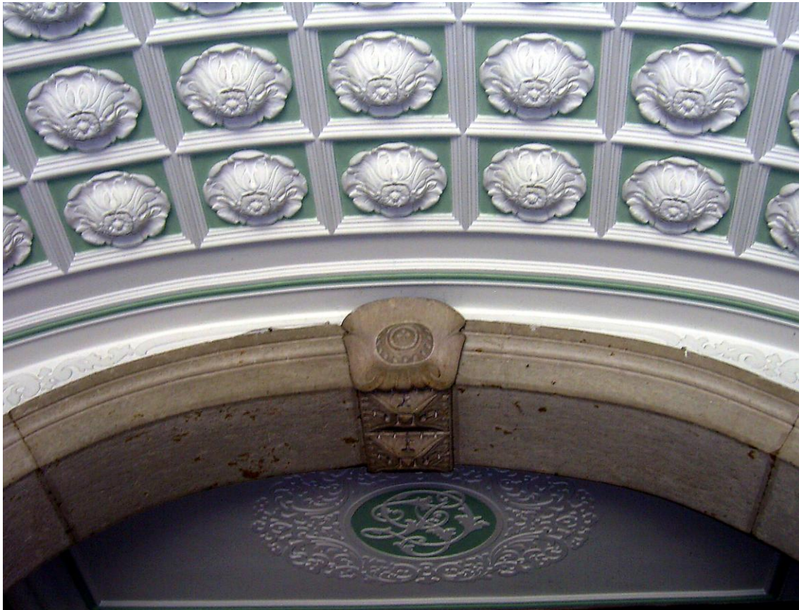
Fig.5 – Apontamentos primorosos na composição dos tectos, sendo visível, também o arco de volta perfeita, com chaves de pedraria com motivos vegetalistas, que antecede o acesso ao piso superior. Crédito fotográfico: Liliana Campeão dos Santos.
