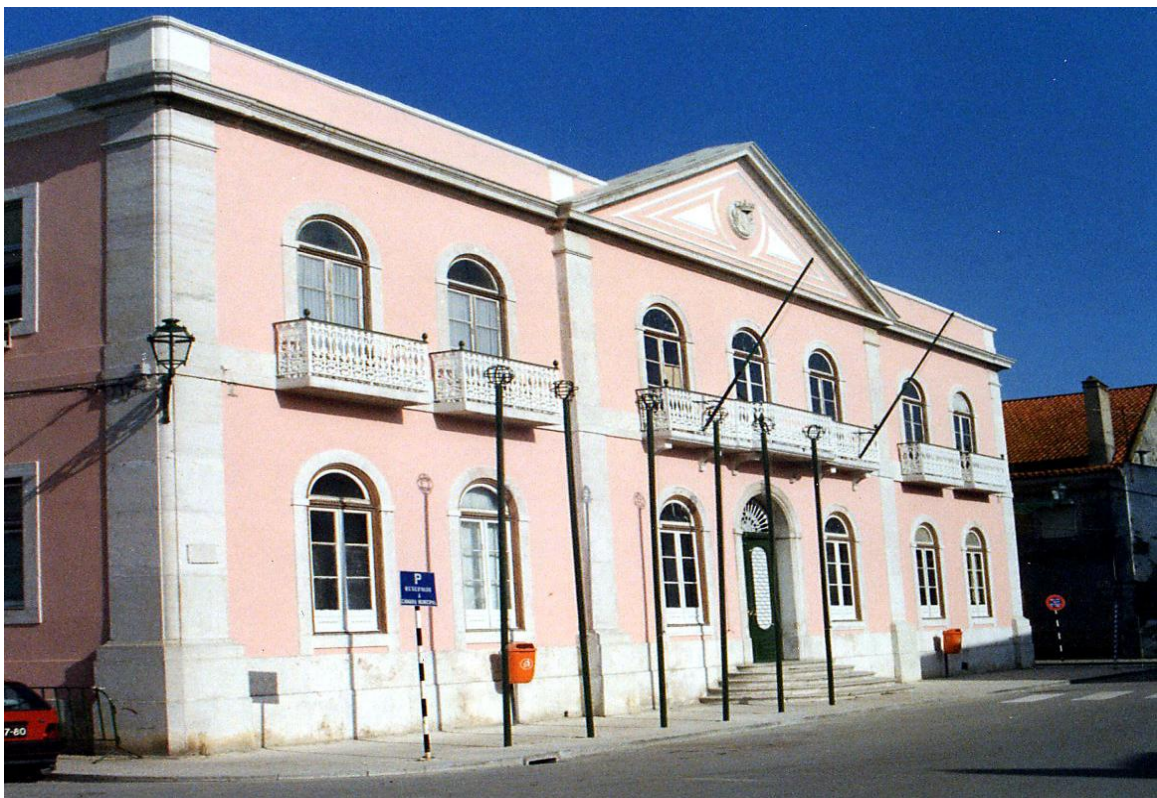
Fig.2 – Edifício dos Paços do Concelho de Montijo. Fonte: Museu Municipal de Montijo.
