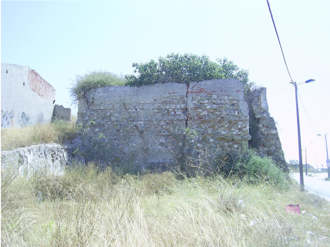
Fig.3 – Fachada lateral do forno e rampa de acesso ao topo do mesmo. Crédito fotográfico: Liliana Campeão dos Santos.
