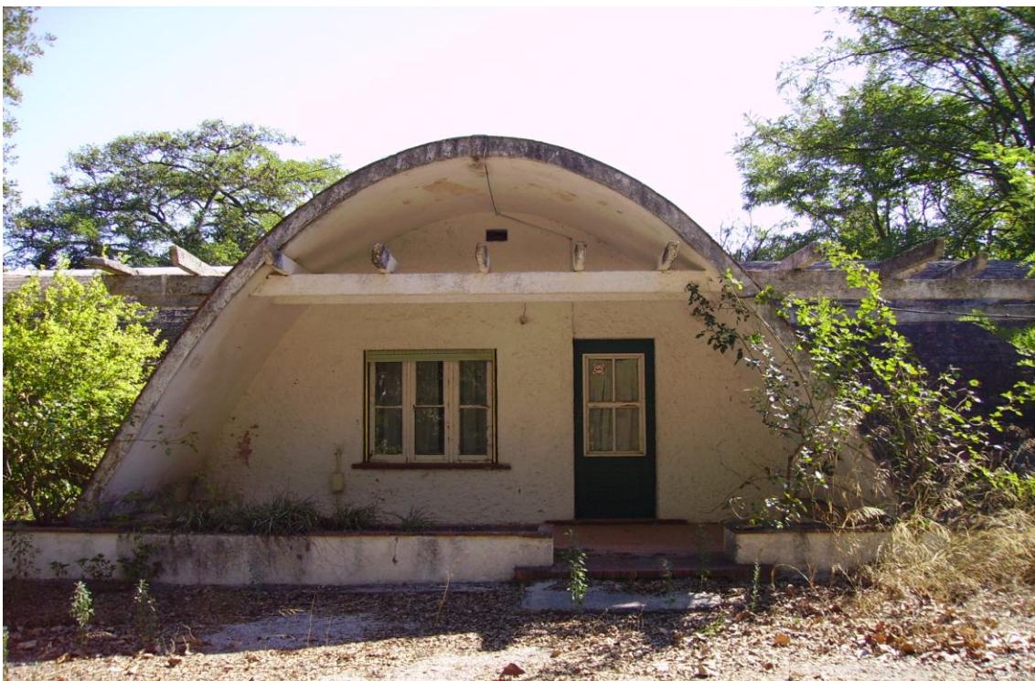
Fig.4 – Fotografia da fachada de uma das casas dos técnicos, localizada no núcleo central da Junta de Colonização Interna de Santo Isidro de Pegões. Crédito fotográfico: Liliana Campeão dos Santos.
