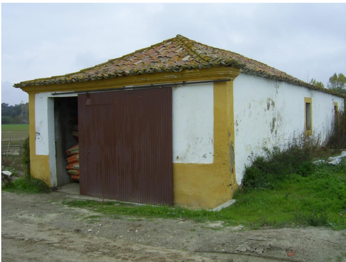
Fig.2 – Fachada do Moinho Novo. Crédito fotográfico: Liliana Campeão dos Santos.
