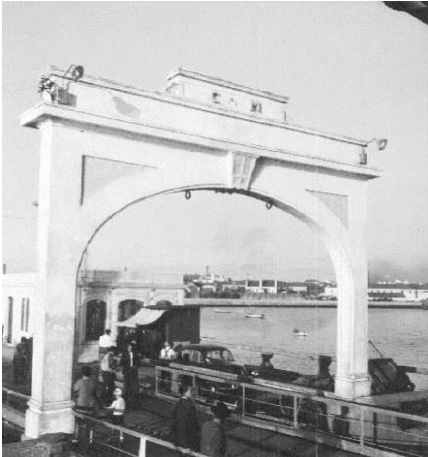
Fig.35 – Fotografia do antigo Arco do Cais dos Vapores, em 1961, antes da sua demolição. Crédito fotográfico: Arnaldo Madureira. Arquivo Fotográfico Municipal de Lisboa.
