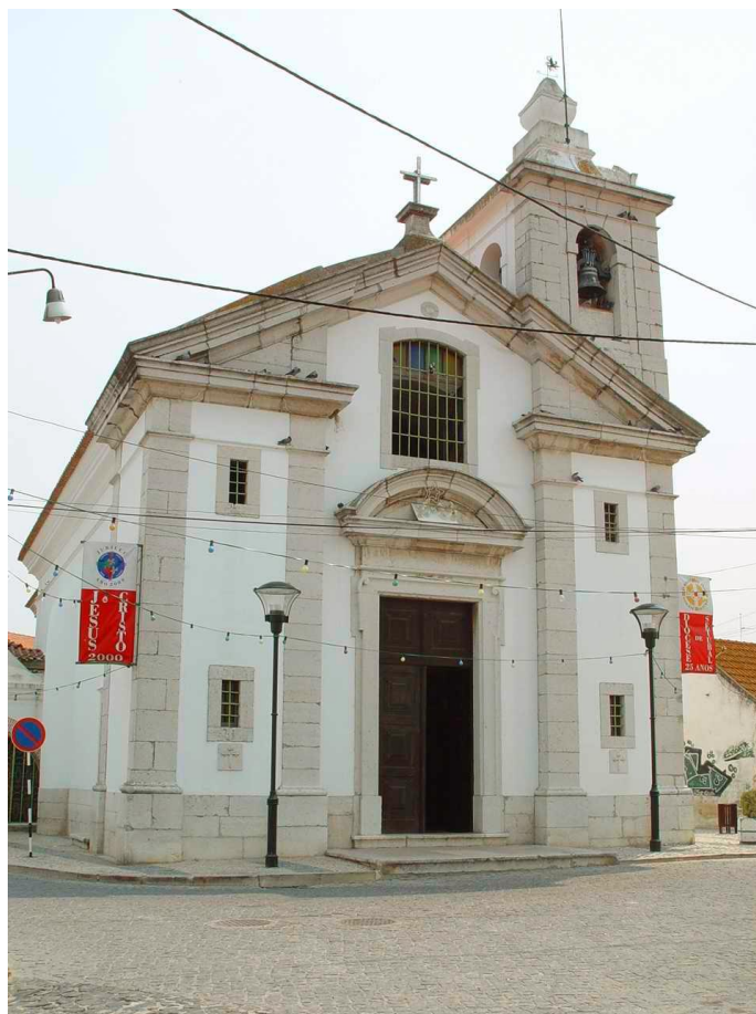
Fig.5 – Fotografia da fachada da Igreja de São Jorge. Crédito fotográfico: Câmara Municipal de Montijo.
