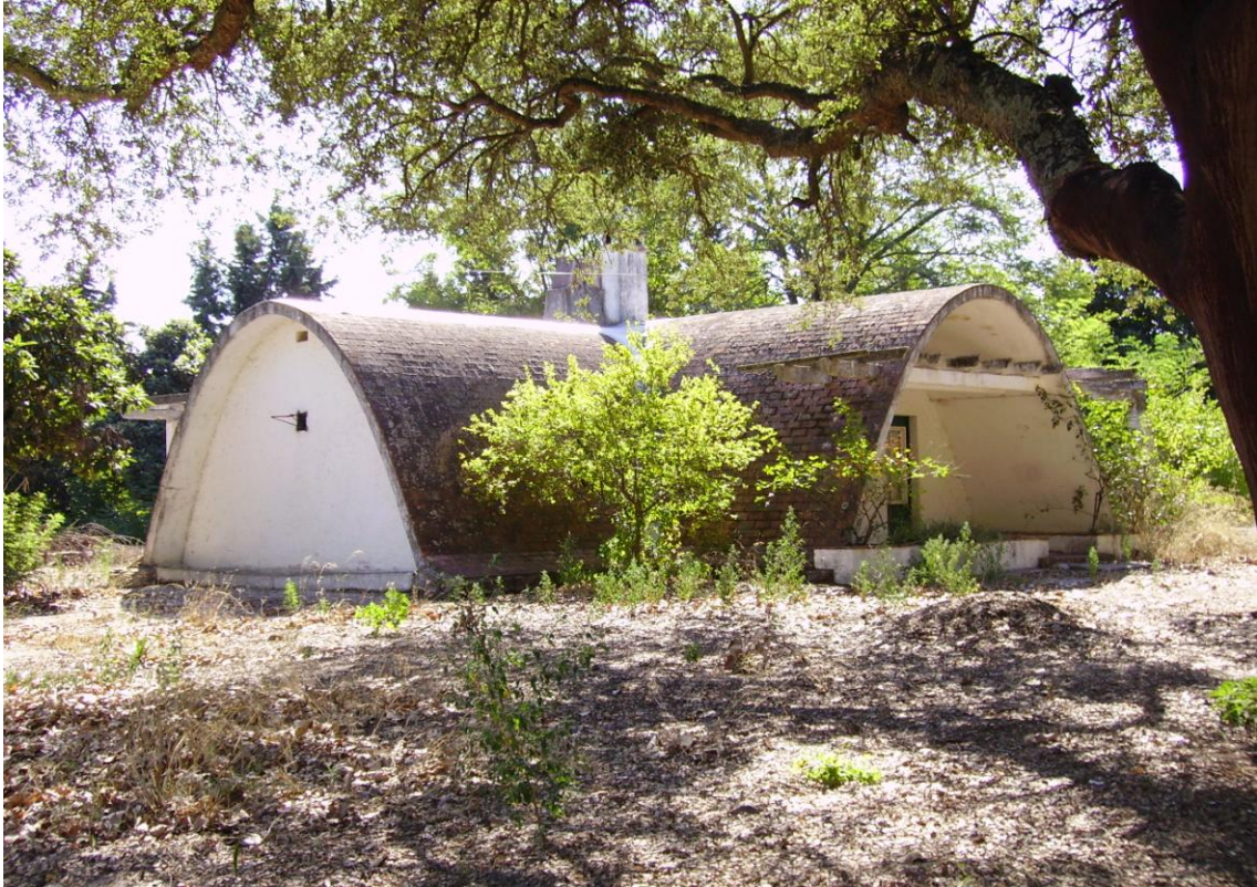
Fig.5 – Fotografia da fachada lateral da mesma casa. Crédito fotográfico: Liliana Campeão dos Santos.
