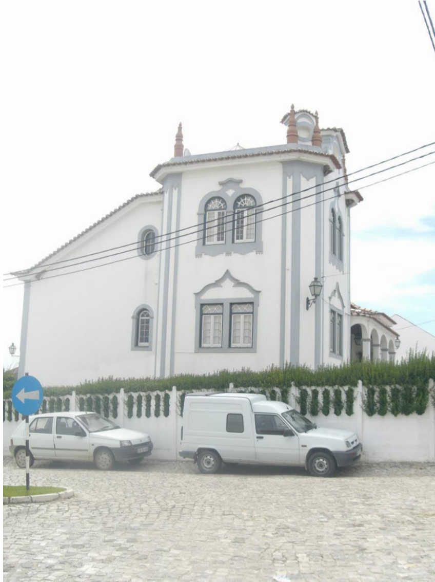
Fig.3 – Fachada lateral da mesma moradia. Crédito fotográfico: Silvério Figueiredo.
