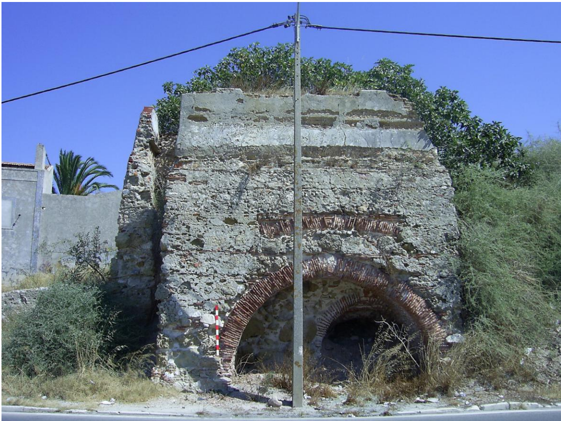
Fig.2 – Fachada de um dos fornos de cal, único do complexo ainda visível. Crédito fotográfico: Liliana Campeão dos Santos.
