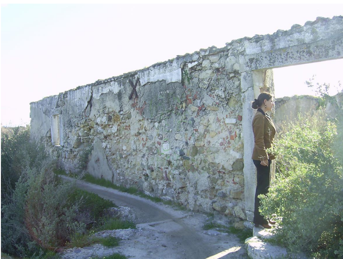
Fig.4 – Parede da fachada do Moinho de Maré da Lançada, visível ainda a porta principal de acesso em cantaria. Crédito fotográfico: Liliana Campeão dos Santos.
