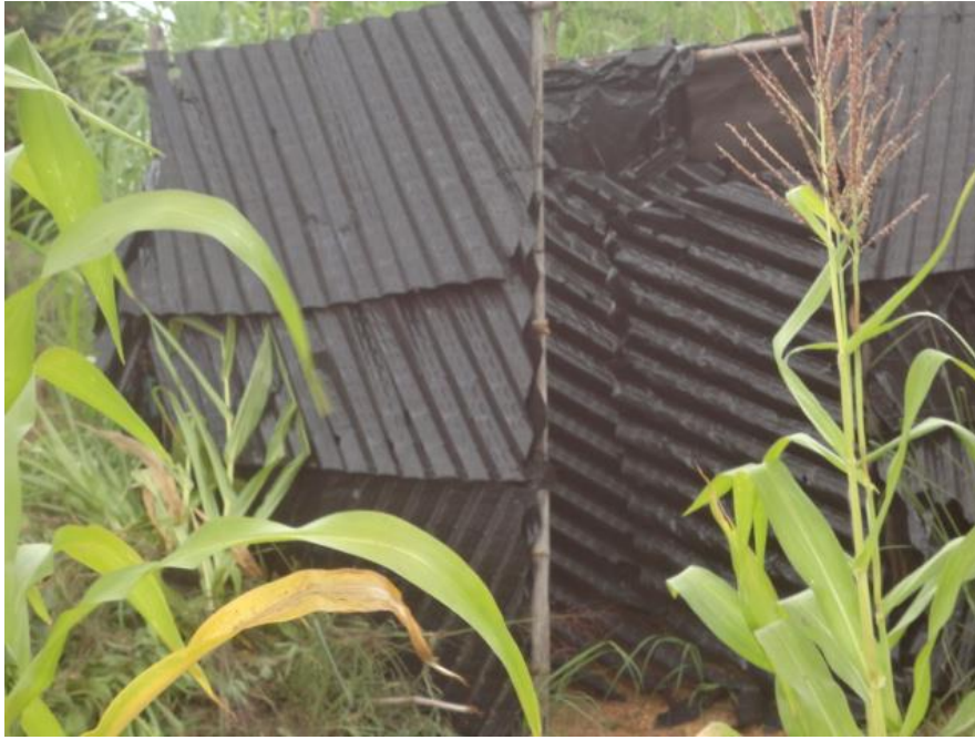
Figura 4.4. Casa de banho feita de telhas de plásticos.
