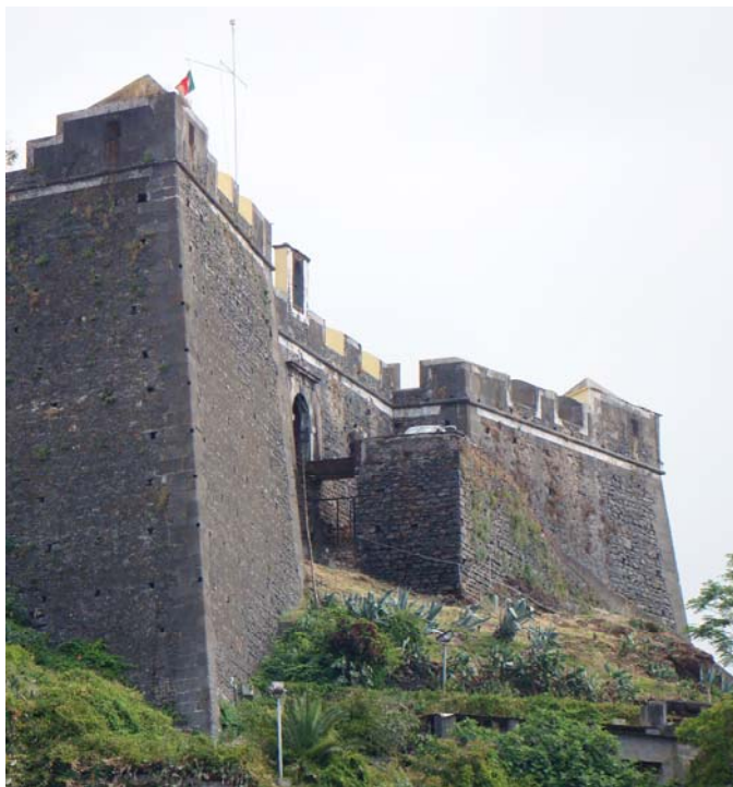
FIGURA 8. Complexo da entrada da fortaleza de São João do Pico. Campanha de c.1602 a 1660. Pico de São João, Funchal.
