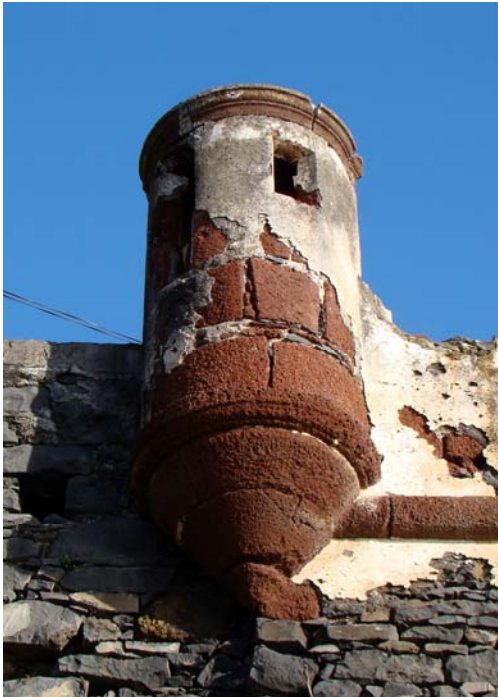
FIGURA 12. Guarita do forte dos Louros. Bartolomeu João, c.1645. Antigo lazareto do Funchal.
