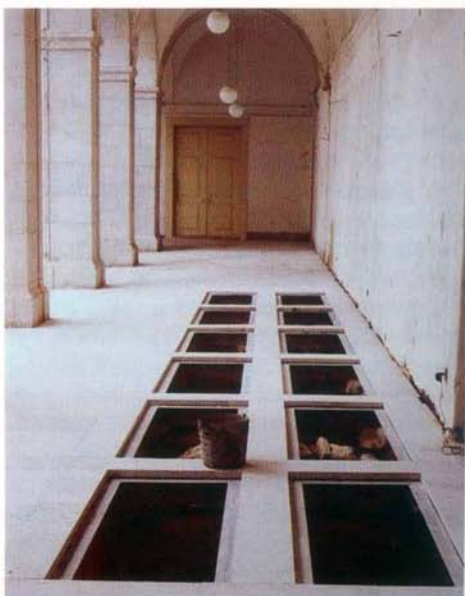
Fig. 8 – Claustro da Academia das Ciências de Lisboa. Vista da ala sul do claustro, observando-se estrutura de ferro e vidro, em fase de conclusão, destinada a permitir a observação parcial dos trabalhos de escavação realizados. Foto JLC.
