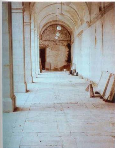
Fig. 7 – Claustro da Academia das Ciências de Lisboa. Vista da ala ocidental do claustro, cujo chão conserva a estrutura esquadriada de lajes e separadores correspondente ao sistema de tabiques de alvenaria identificados na ala escavada, onde tal revestimento se não conservou. Observe-se a existência de lajes numeradas, identificadoras das diversas tumulações efectuadas no alvéolo correspondente. Foto JLC.
