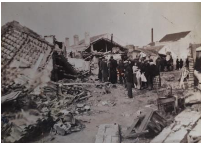
FIGURA 10 | Destruição provocada pelo ciclone de 15 de fevereiro de 1941, no Montijo. Algumas casas de pescadores foram inundadas e os seus pertences danificados. Na casa do arrais António Nunes, na Travessa do Escrivão, o nível da água subiu 1,20 m da soleira da porta de entrada. Cedida gentilmente pela Sociedade Cooperativa União Piscatória Aldegalense (SCUPA), em 21/12/2019.
