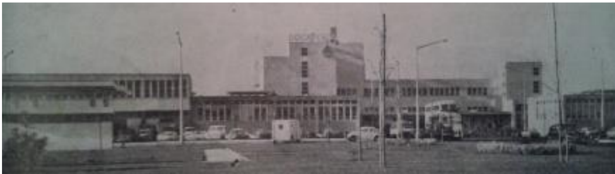
FIGURA 30 | Edifício da Docapesca em Pedrouços (1970).
