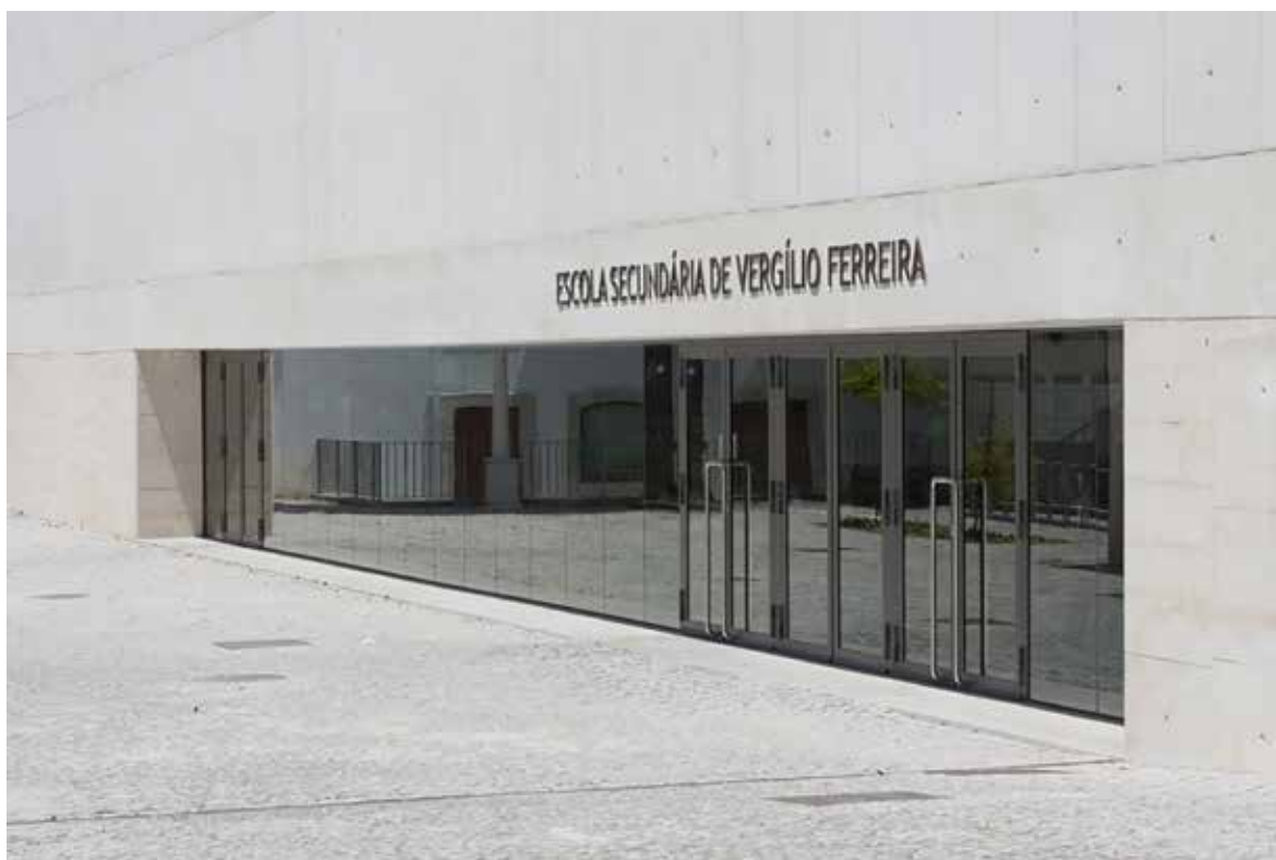
Fotografia 11. Exterior edifício Escola Secundária Vergílio Ferreira (site AEVF)
