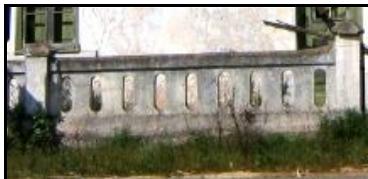
Fig. 51 - Muro de vedação da casa de cantoneiros de S. Teotónio
