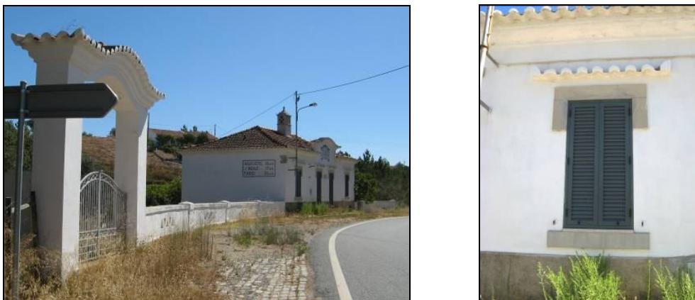
Fig. 58 – Casa de cantoneiros de Vale de Maria Dias: pormenores do portão e da caixilharia.
