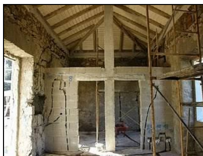
...e durante as obras.
