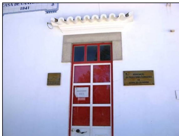
Fig. 64 – Casa de cantoneiros de Sto. Isidro, sede da Associação de Produtores Florestais da Serra do Caldeirão
