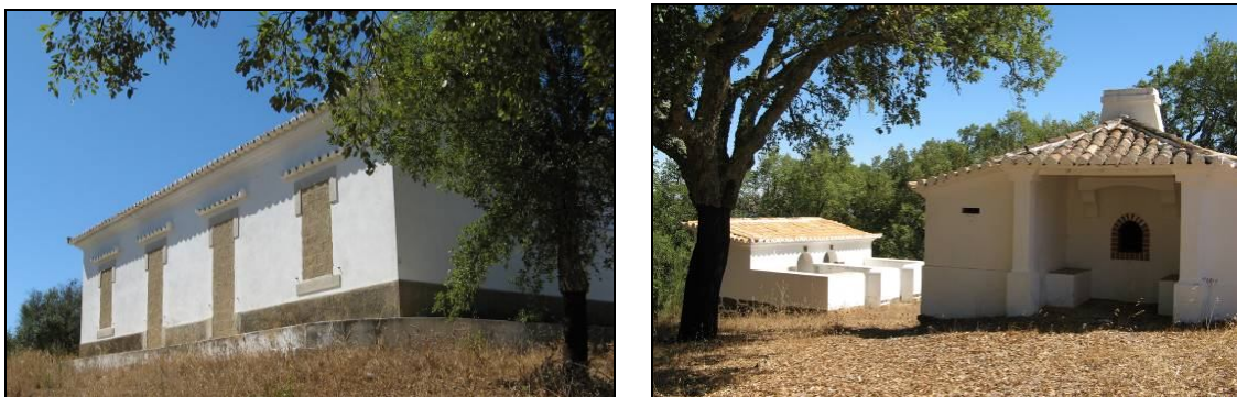
Fig. 57 – Casa de cantoneiros de Cavalos: traseiras e anexos (sanitários e forno).
