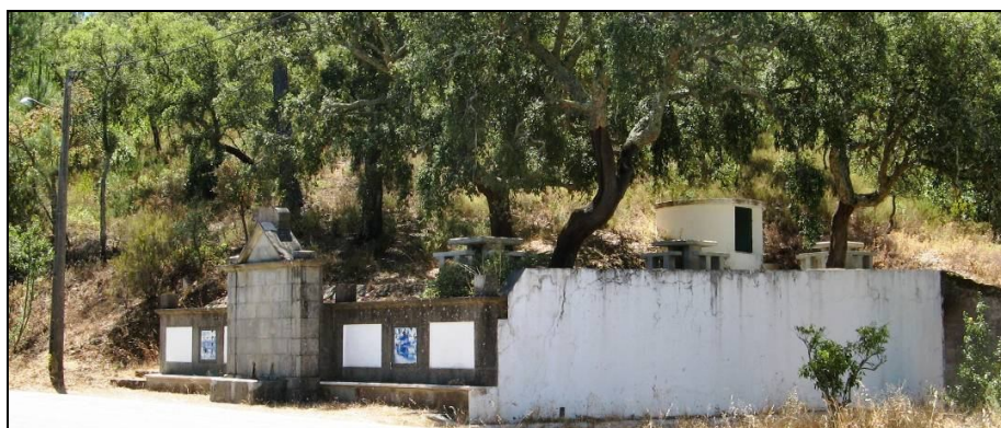
Fig. 61 – Chafariz e parque de merendas de Bicas da Serra.
