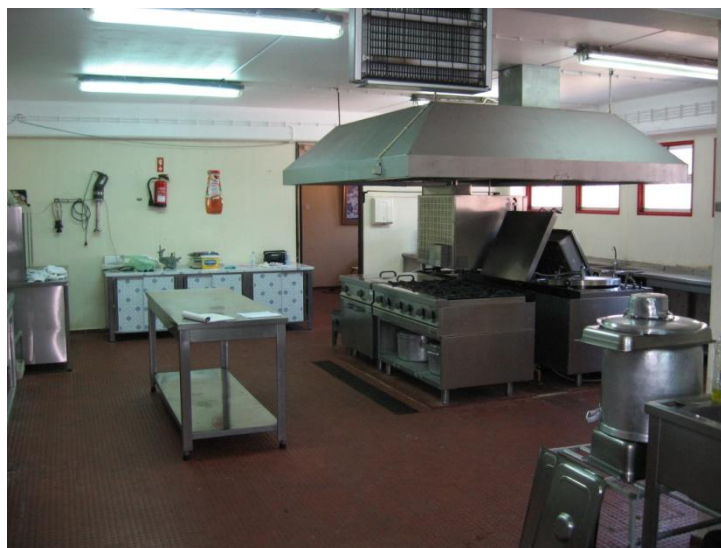
Figura 7: Zona da cozinha (ponto 1 da planta)
