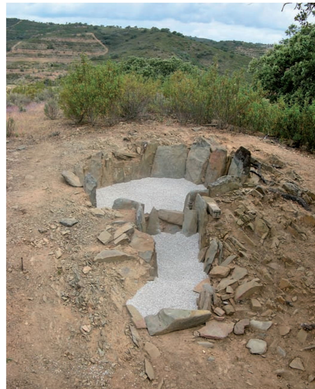
Fig. 18 – Aspecto final da consolidação executada com colocação de blocos de grauvaque sobre geotêxtil estendido em todo o seu interior e embalado em matriz terrosa, posteriormente coberta por camada de gravilha miúda.
