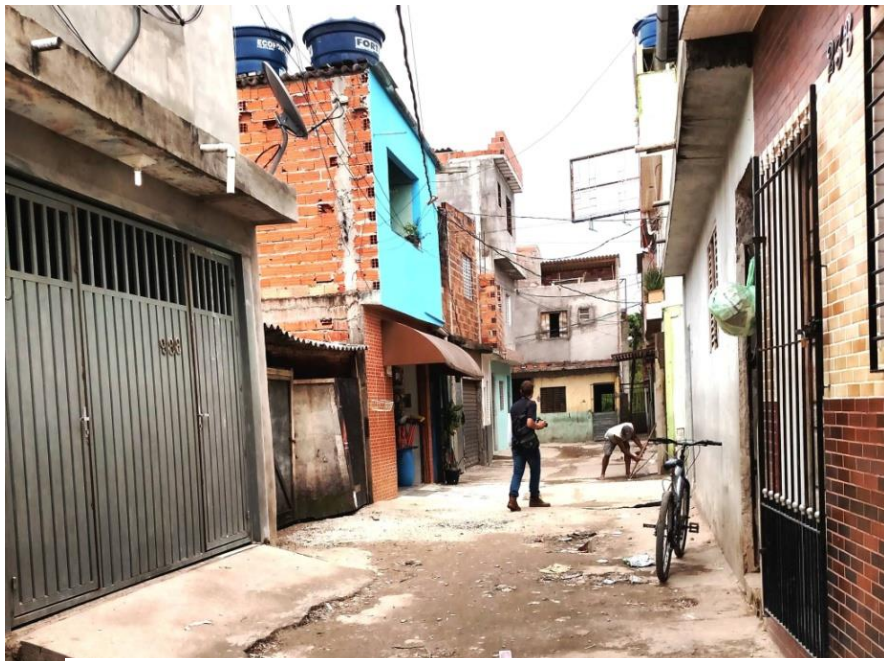
Figura 5 casas construídas em becos e vielas - 2
