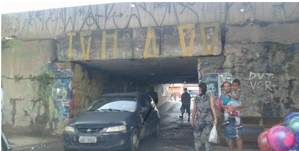
Figura 11 túnel de acesso ao bairro
