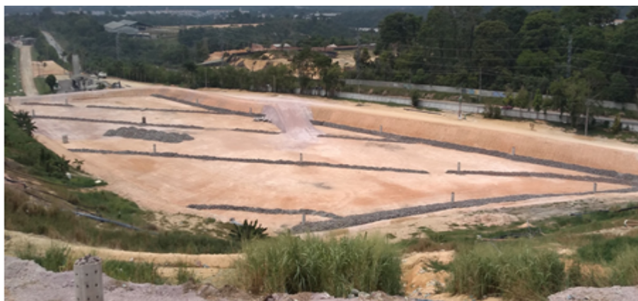
Figura 5.18: Área preparada com impermeabilização e rede de coleta de chorume e biogás, para passar a receber a deposição de resíduos
