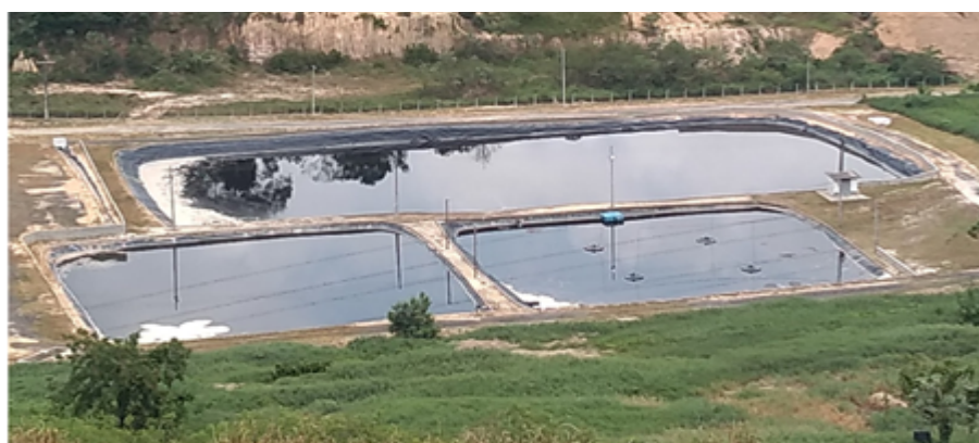
Figura 5.19: Lagoas para tratamento do chorume
