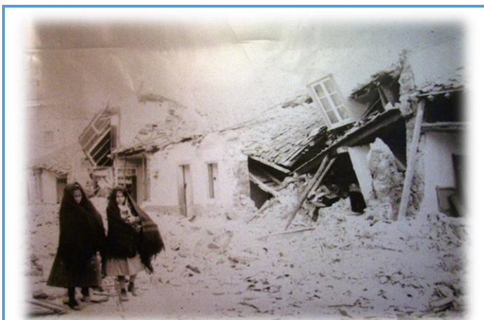
Figura 5.43. Locais de Samora Correia após Terramoto de 1909
