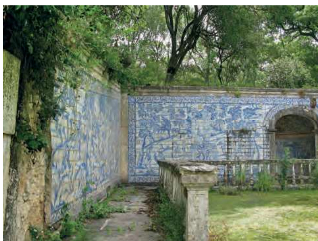
Fig. 13 – Revestimento azulejar do tanque da Quinta das Lapas.
