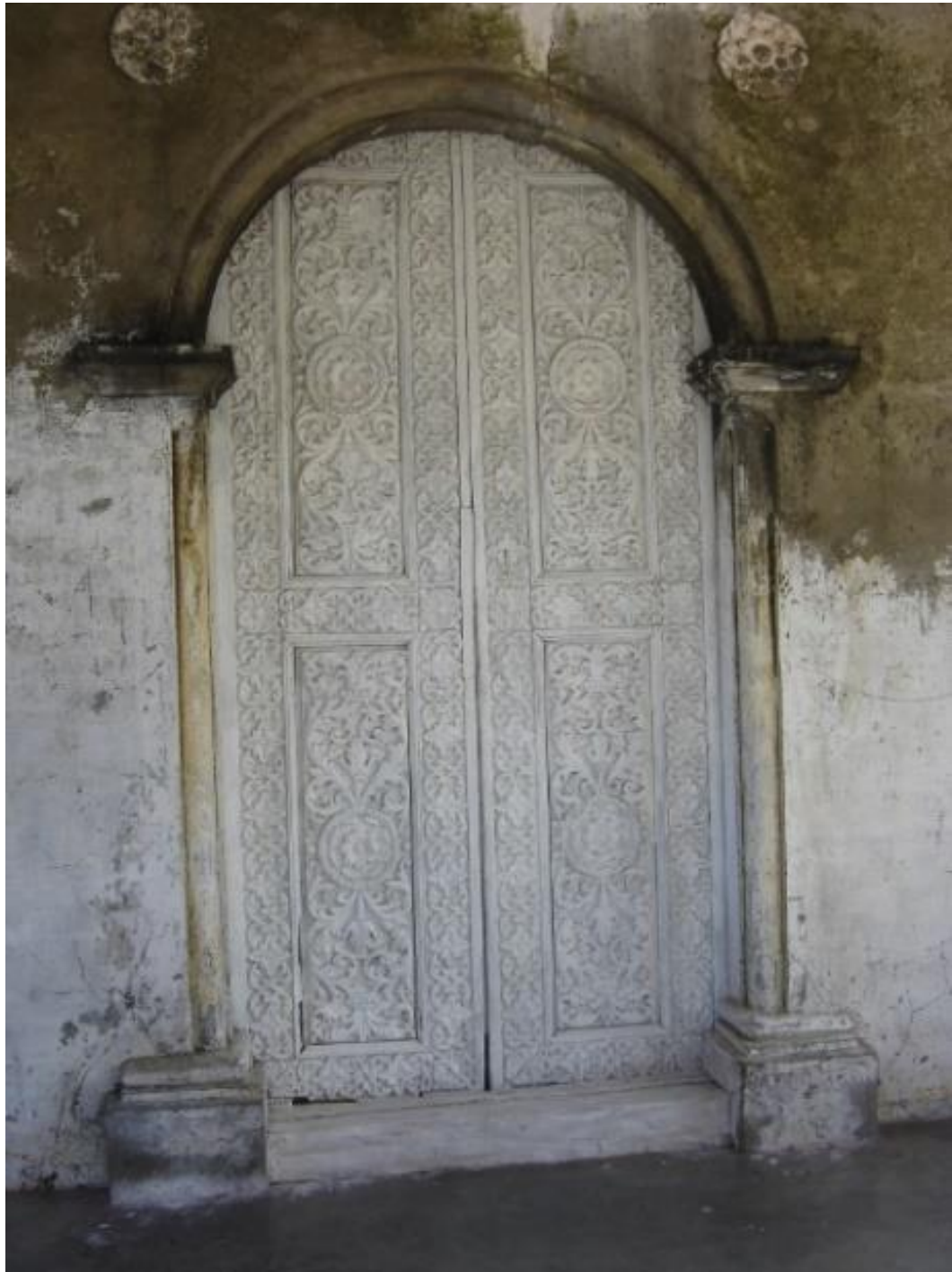
Fig. 2.14- Porta da Igreja de Nossa Senhora dos Remédios. Detalhe da talha ornamentada com elementos decorativos ao gosto indiano. Cabaceira Grande.
