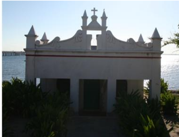
Fig. 2.4- Fachada Capela de S. Francisco Xavier. Ilha de Moçambique.
