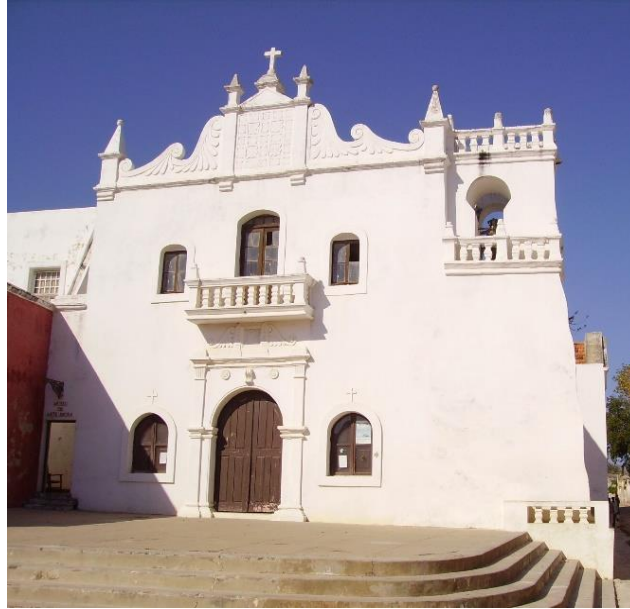
Fig. 2.1- Vista geral da fachada da Igreja da Misericórdia da Ilha de Moçambique. Fotografia da autora, Ilha de Moçambique, abril de 2008.
