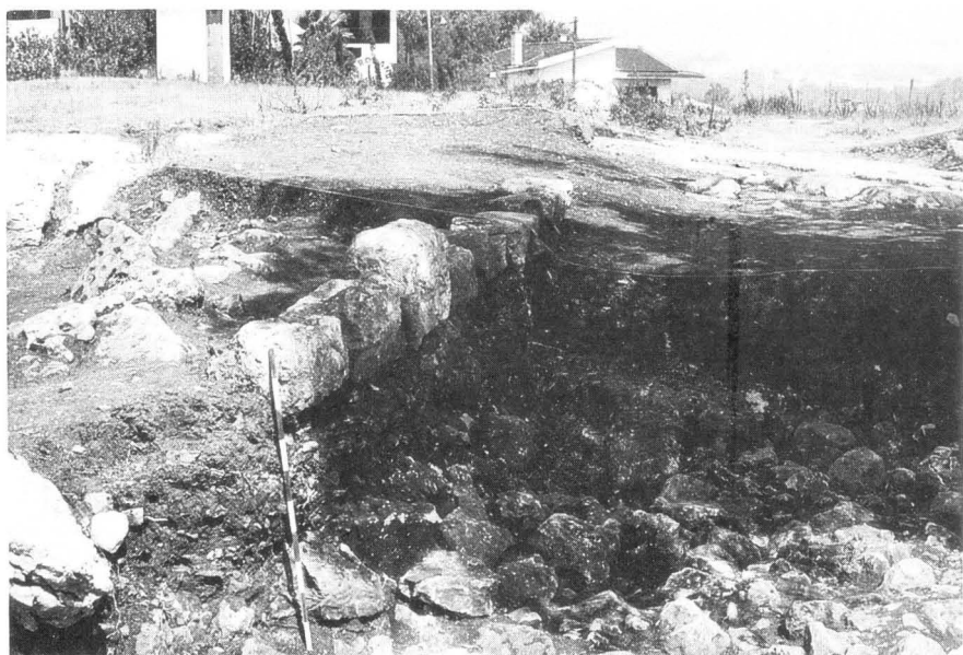
Fig. 5 — Vista parcial do troço melhor conservado do caminho, delimitado de ambos os lados por grandes blocos calcários não aparelhados. (Foto de J. L. Cardoso).
