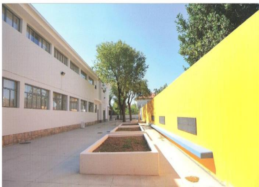
Fig.3. 2 – Escola Básica Conde de Ferreira – Passagem Lateral
