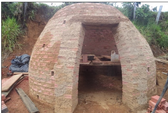
Figura 3: Forno em construção.
