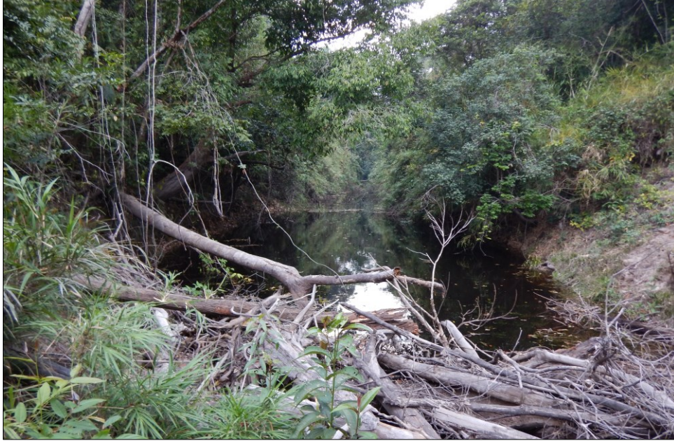
Figura 17: Obstrução de curso de água por galhos de árvores.
