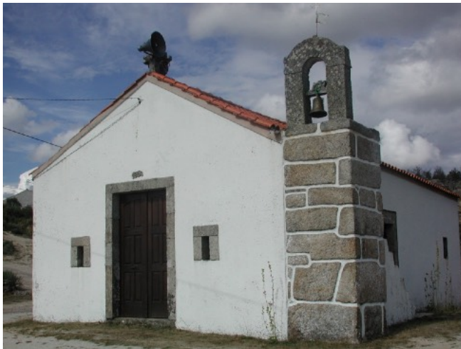
Fig. 16: Capela de S. Brás (Montes — Trancoso) (Fonte: Fotografia César Prata)
