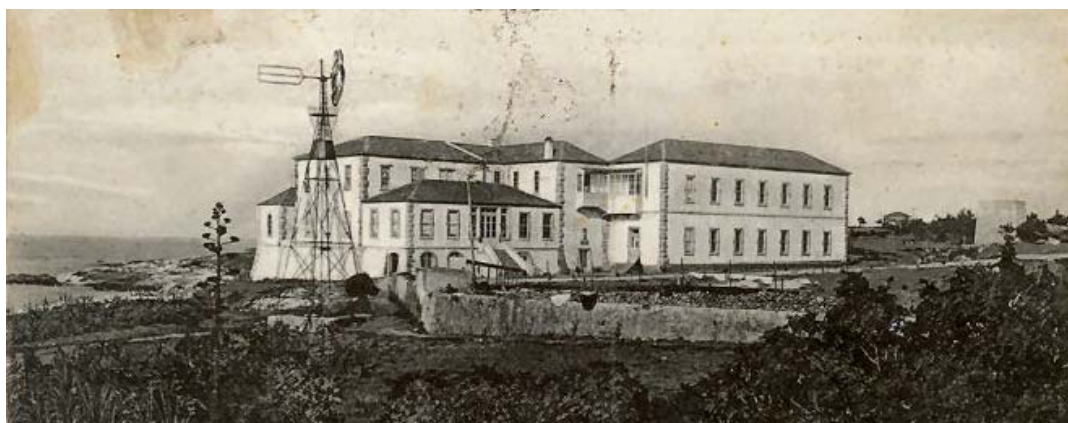
Figura nº 4 – Sanatório Marítimo de Carcavelos (1902)
