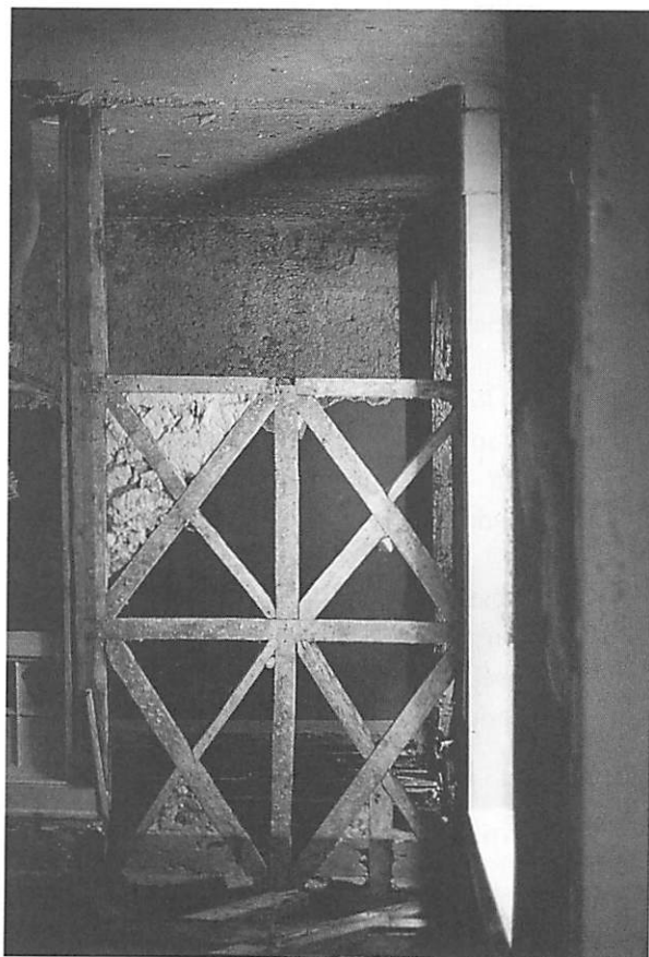
Pormenores de uma estrutura de gaiola , observados num edifício da Baixa
