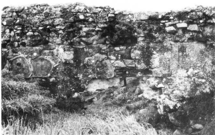
Fot. 49 — Barragem do Muro dos Mouros (Serpa). Paramento de montante, notando-se a fistula, de cerâmica, sobre a saída da linha de água actual.
