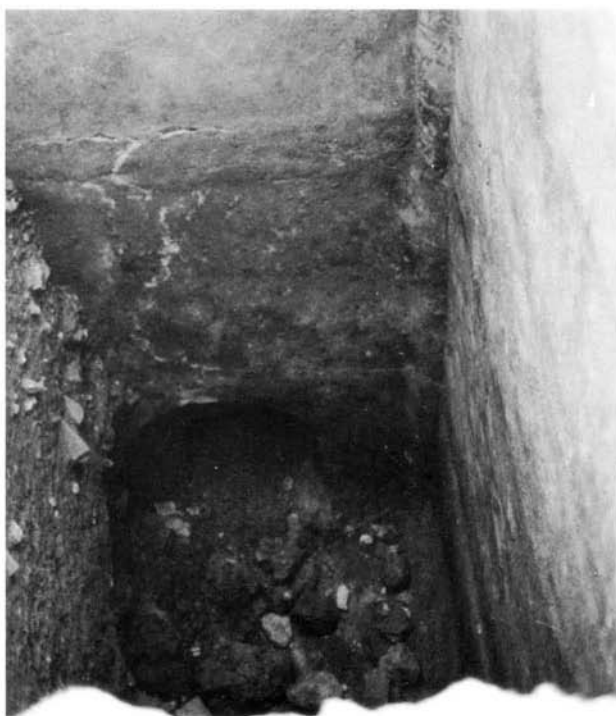
Fot. 112 — Cisterna de Portimão Fotografia C. M. Beirão.
