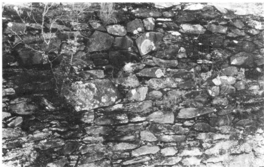
Fot. 70 — Barragem da Represa (Gavião). Pormenor do paramento interno do muro de montante.
