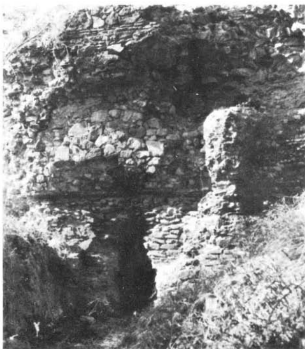
Fot. 8 — Barragem do Muro (Campo Maior). Saída da linha de água, correspondendo provavelmente à antiga descarga de fundo.
