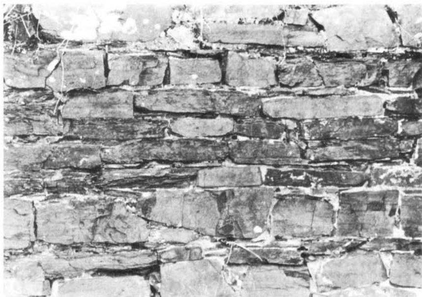
Fot. 56 — Barragem do Álamo (Alcoutim). Pormenor do paramento de jusante.
