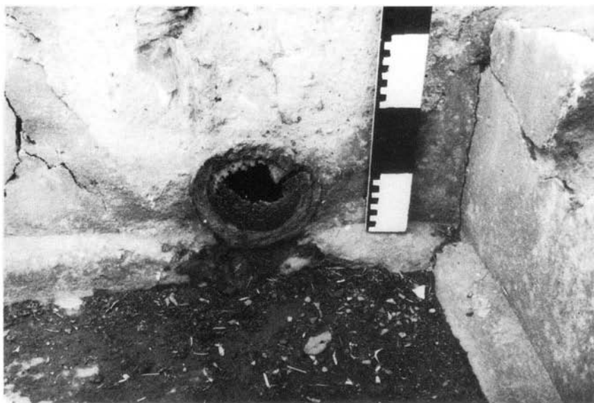
Fot. 121 — Cerro da Vila (Loulé) . Ralo de bronze existente junto do fundo de tanque de sedimentação.
