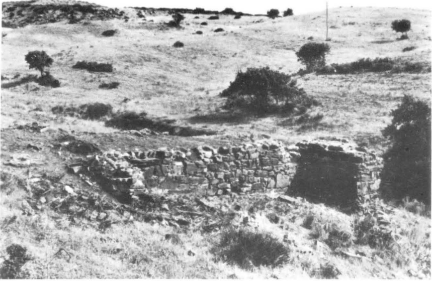
Fot. 57 — Barragem de Santa Rita (Vila Real de Santo António). Vista de jusante, da encosta direita.
