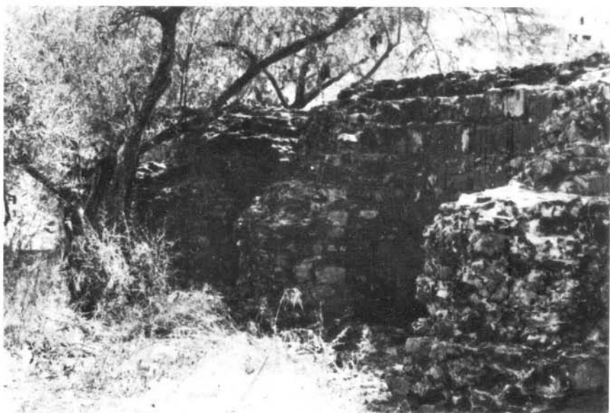
Fot. 54 — Barragem do Álamo (Alcoutim). Vista de jusante.
