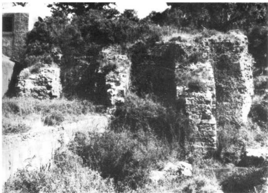
Fot. 89 — Barragem de Olisipo (Sintra). Vista de jusante.
