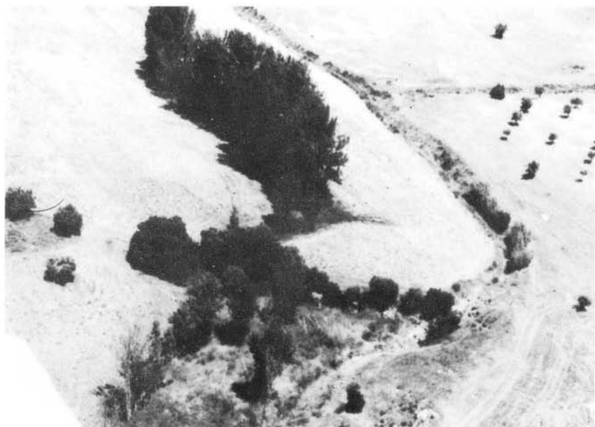
Fot. 32 — Barragem do Muro da Prega (Beja). Fotografia aérea oblíqua, de jusante.
