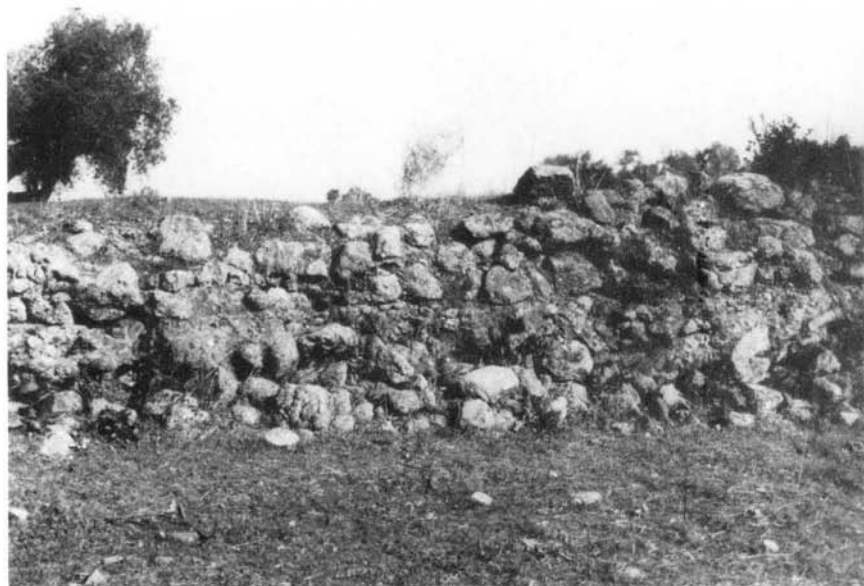
Fot. 2 — Barragem da Tapada Grande (Castelo de Vide). Paramento de montante.
