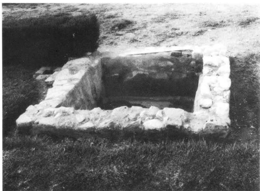
Fot. 122 — Cerro da Vila (Loulé) . Tanque de sedimentação com ralo (ver Fot. 121).
