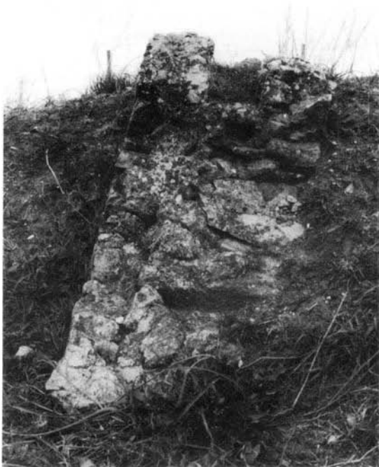
Fot. 115 — Canal da Fonte dos Frades (Beja).
