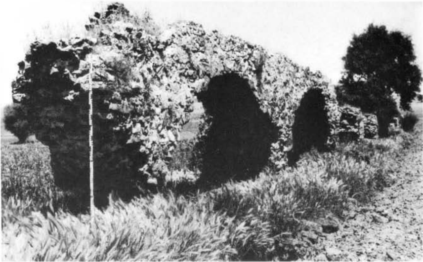
Fot. 123 — Aqueduto do Correio-Mor (Elvas). Vista parcial.
