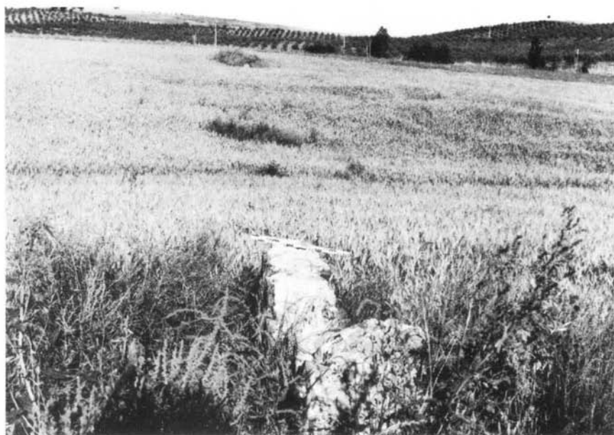
Fot. 15 — Barragem da Mourinha (Campo Maior) . Vista do troço conservado, na encosta direita. O encontro da margem esquerda corresponde ao maciço de vegetação visível ao fundo.
