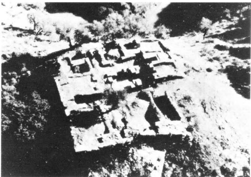
Fot. 110 — Cisterna do Castelo da Lousa (Mourão), no centro da fortificação. Fotografia de PAÇO e LEAL 1966.
