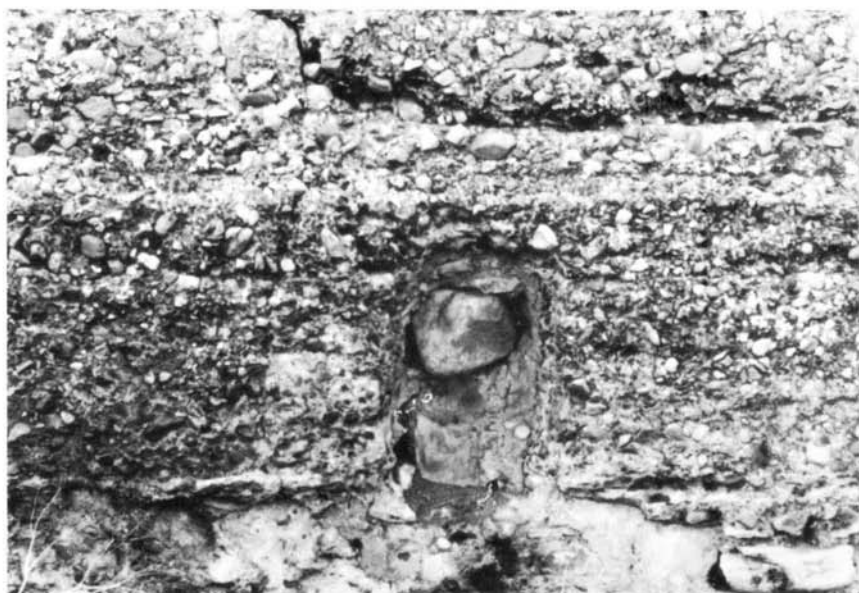
Fot. 22 — Barragem de Moralves (Elvas). Possível descarga de fundo ou tomada de água, colmatada, observável do lado de jusante.
