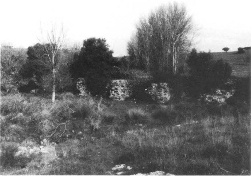
Fot. 33 — Barragem do Muro da Prega (Beja). Vista de jusante.
