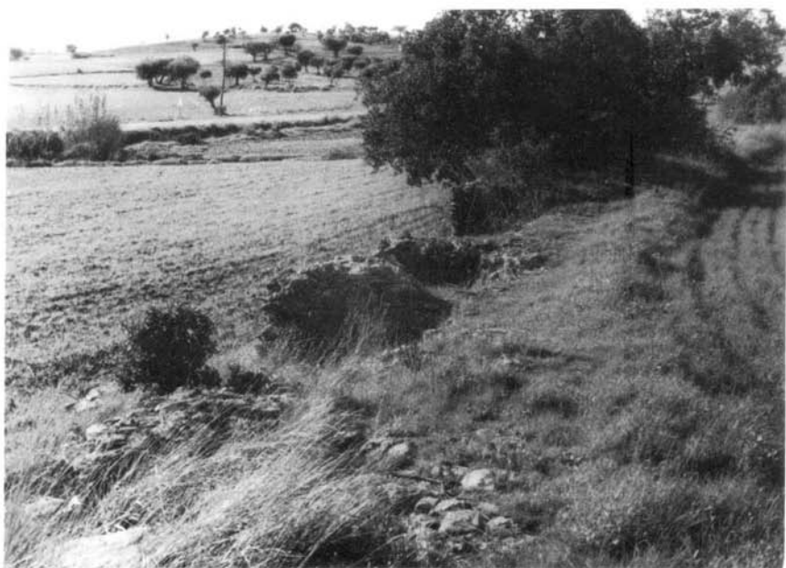
Fot. 30 — Barragem de Nossa Senhora da Represa (Cuba). Observa-se o assoreamento da antiga albufeira, à direita.
