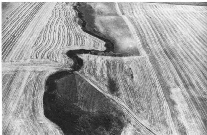
Fot. 17 — Barragem de Moralves (Elvas) . Fotografia aérea oblíqua, de jusante. A linha de água desviou-se para a zona do encontro direito.
