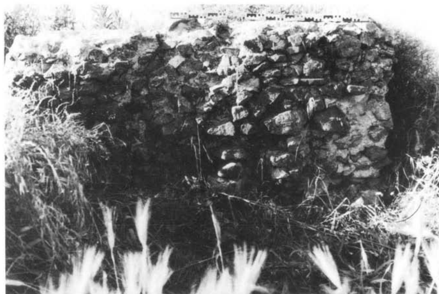
Fot. 16 — Barragem da Mourinha (Campo Maior) . Pormenor do aparelho construtivo (opus incertum).
