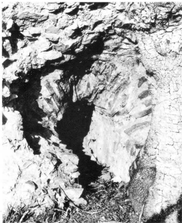
Fot. 42 — Barragem de Pisões (Beja) . Pormenor da descarga de fundo, de jusante, com aparelho de tijoleira, encoberto à direita, pelo tronco da árvore.
