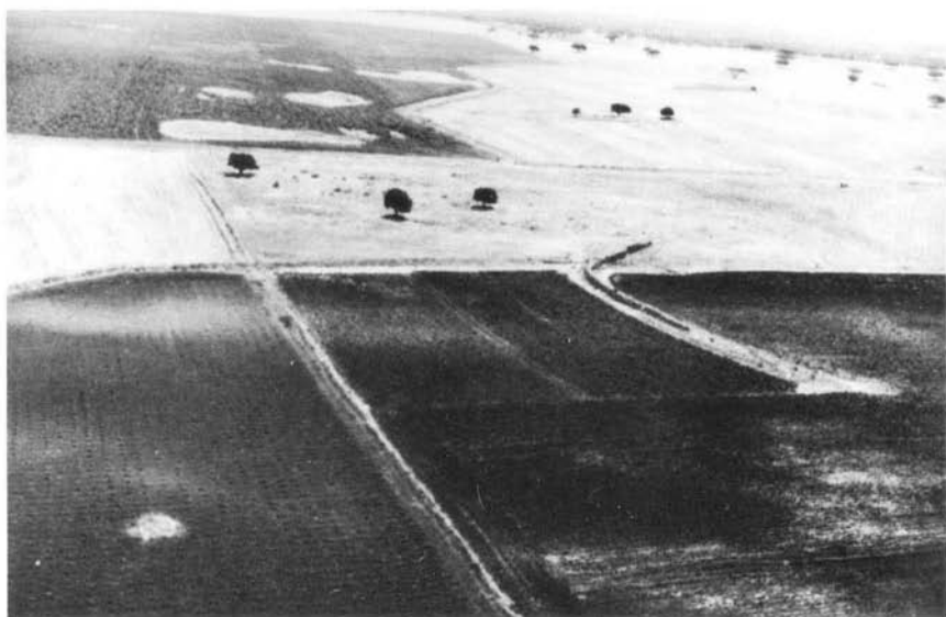
Fot. 47 — Barragem do Muro dos Mouros (Serpa). Fotografia aérea oblíqua, de jusante.
