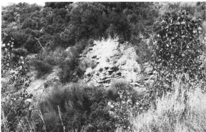
Fot. 83 — Barragem da Idanha-a-Velha (Idanha-a-Nova) . Talude originado pela ruptura da barragem, observado da margem esquerda.
