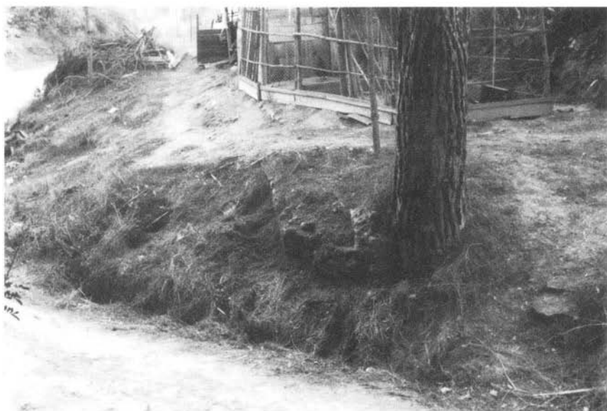
Fot. 126 — Aqueduto de Alcácer do Sal, seccionado por caminho. Evidencia-se o enchimento interior de tijolo britado da cobertura).
