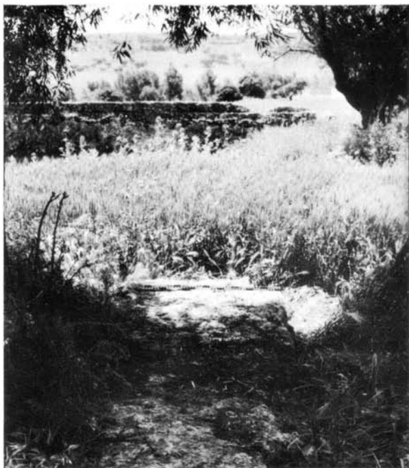
Fot. 113 — Canal subterrâneo do Correio-Mor (Elvas) para abastecimento do tanque, em segundo plano.
