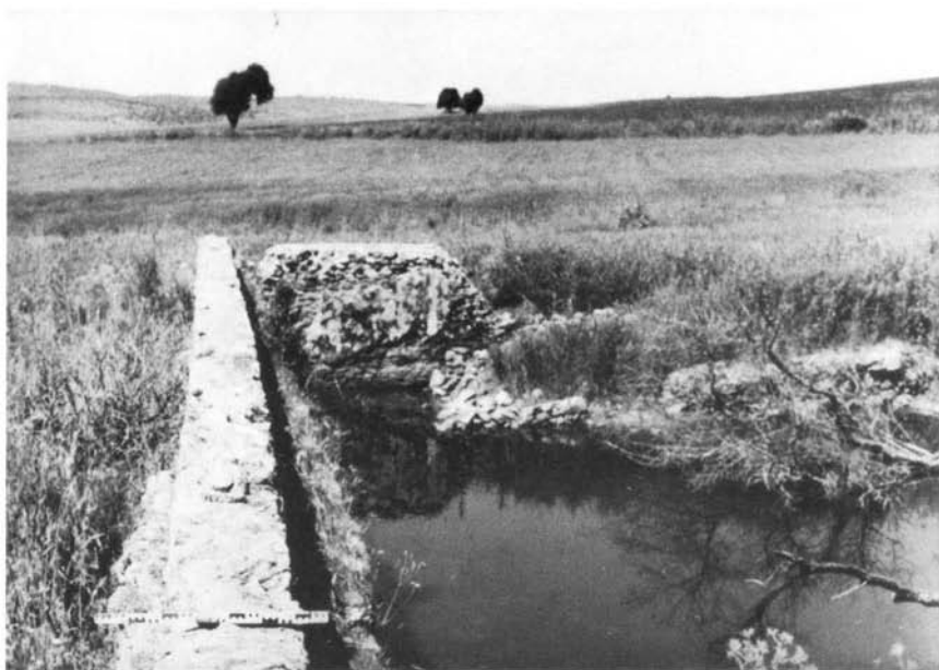
Fot. 101 — Tanque do Correio-Mor (Elvas). Vista do canto sudeste, observando-se o parapeito do muro meridional do tanque.
