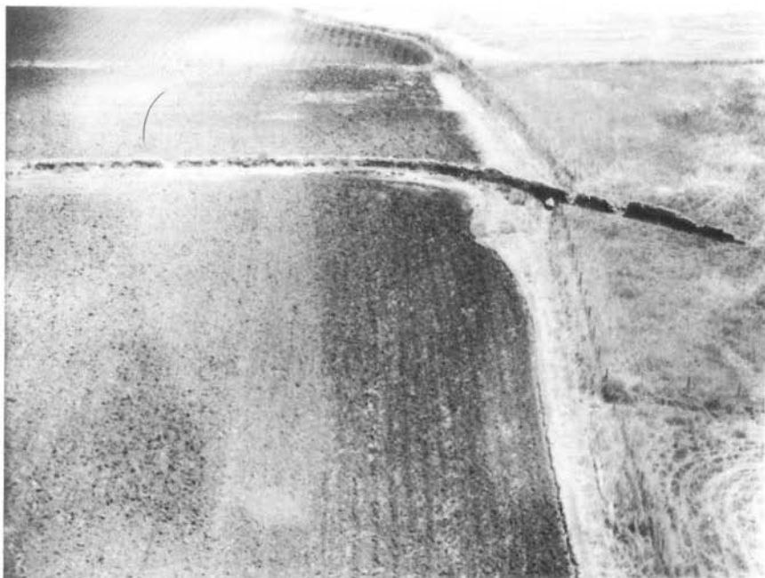
Fot. 46 — Barragem do Muro dos Mouros (Serpa). Fotografia aérea oblíqua, de montante.
