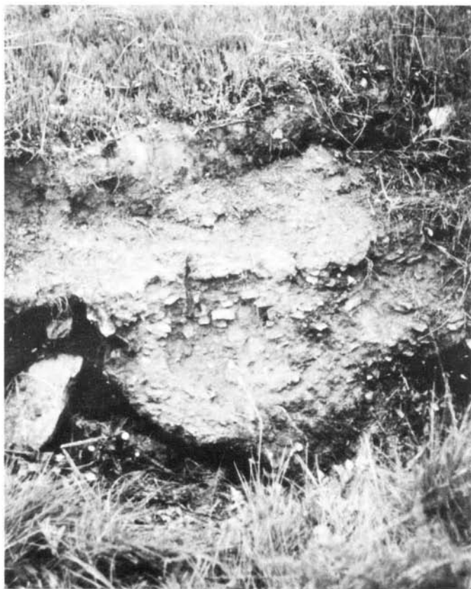
Fot. 52 — Barragem do Monte Novo do Castelinho (Amodôvar). Pormenor do aterro, cortado pelo curso de água.
