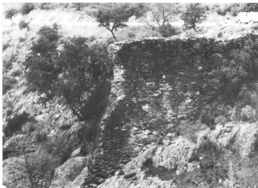
Fot. 68 — Barragem da Represa (Gavião). Vista do muro de montante, assente sobre o maciço rochoso, de natureza xistosa.
