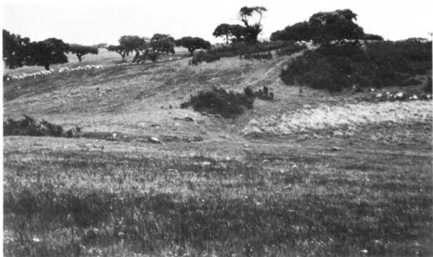
Fot. 51 — Barragem do Monte Novo do Castelinho (Almodôvar). Vista de jusante.
