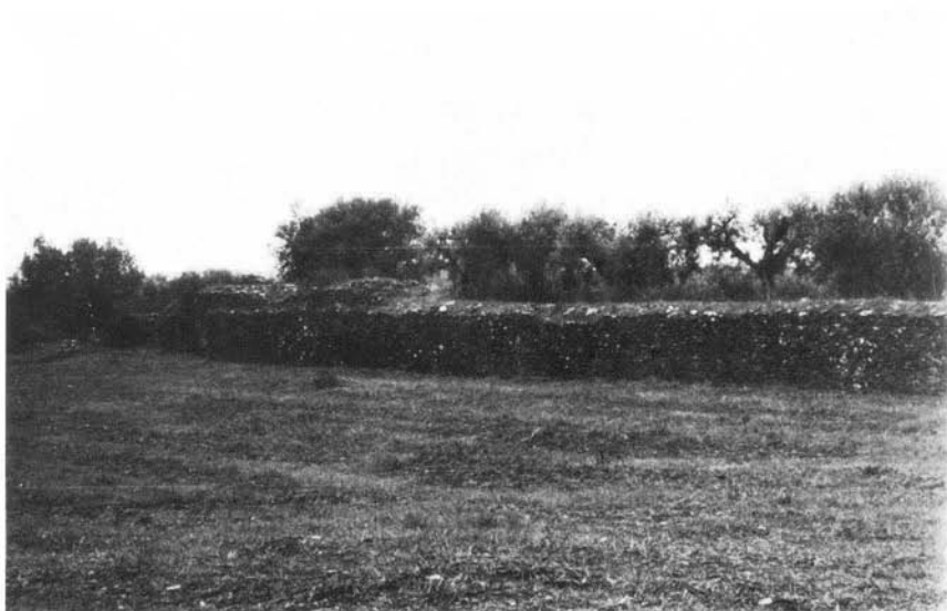
Fot. 104 — Tanque dos Mouros (Estremoz). Vista da face interna do muro sul-ocidental do tanque.
