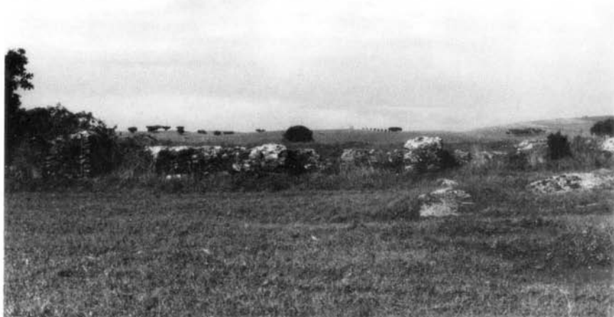
Fot. 29 — Barragem de Nossa Senhora da Represa (Cuba). Vista parcial de jusante.
