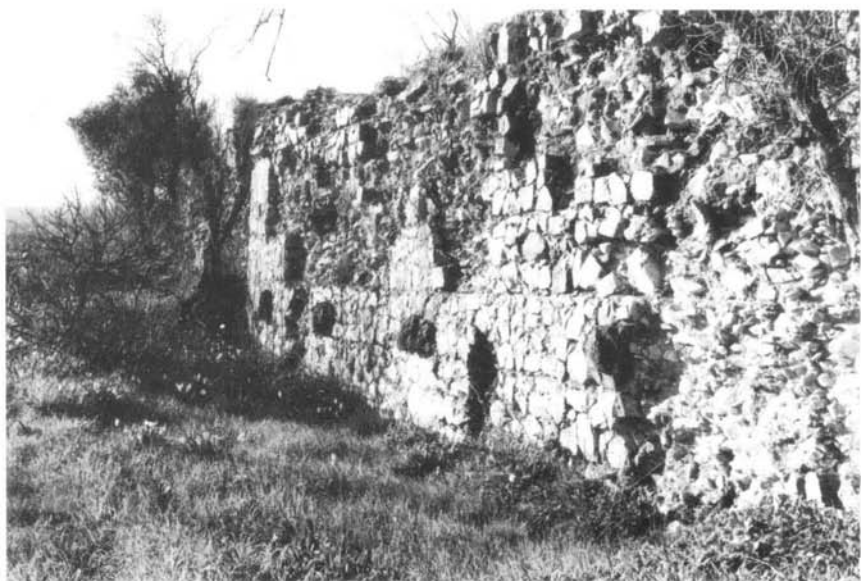
Fot. 40 — Barragem de Pisões (Beja). Vista de jusante, com o revestimento exterior parcialmente conservado.
