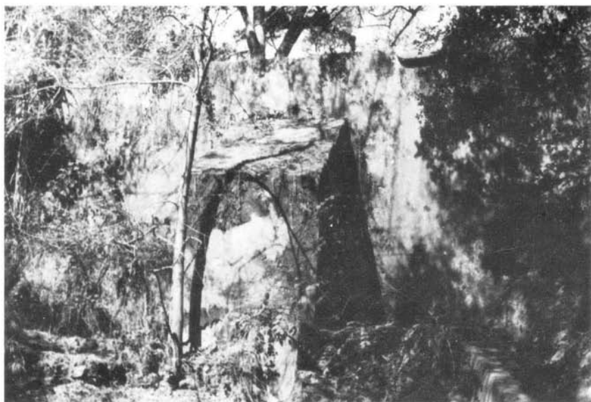
Fot. 25 — Barragem da Comenda (Setúbal). Vista de jusante, com o contraforte.
