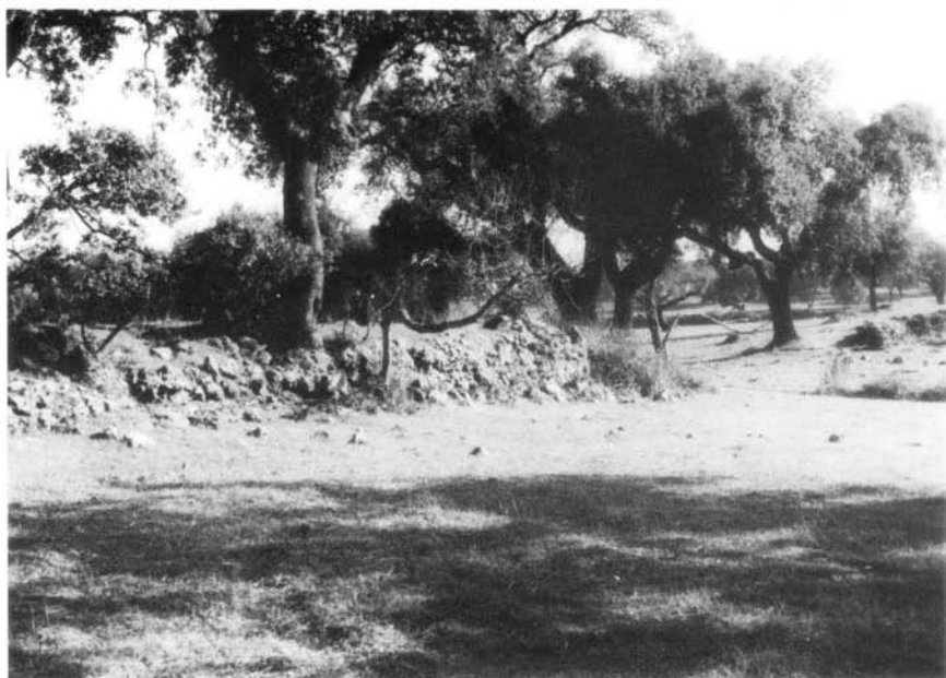
Fot. 1 — Barragem da Tapada Grande (Castelo de Vide). Vista de montante, notando-se o aterro, a jusante.
