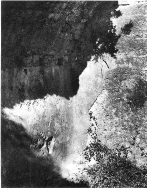
Fot. 108 — Cisterna do Casal do Bispo (Sesimbra). Vista parcial, mostrando a junção entre duas paredes laterais, através de canto arredondado. Revestimento de opus incertum.
