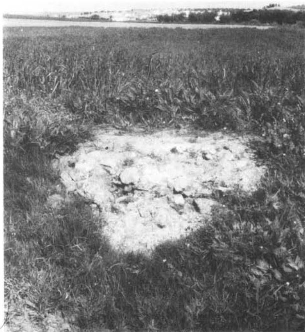
Fot. 36 — Barragem das Hortas de Baleizão (Beja). Pormenor construtivo do muro.
