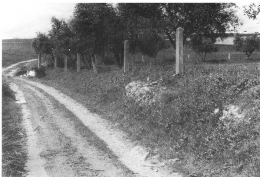
Fot. 35 — Barragem das Hortas de Baleizão (Beja). Vista do troço do muro, na margem esquerda, de jusante.
