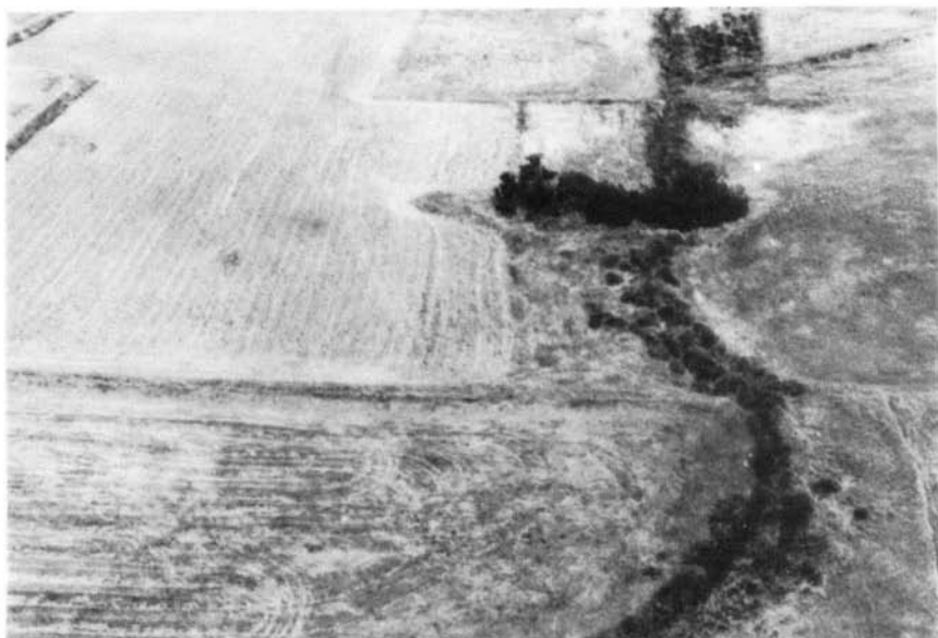
Fot. 13 — Barragem de Olivã (Campo Maior). Fotografia aérea oblíqua, de jusante. A barragem está coberta pelo maciço de vegetação transversal à linha de água.
