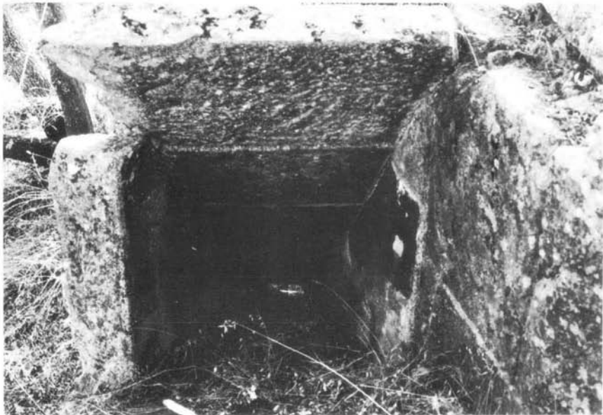
Fot. 78 — Barragem da Cabeça Pelada (Alcains). Pormenor do cubo da roda hidráulica.
