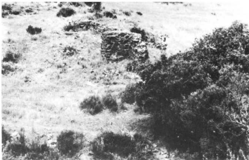
Fot. 59 — Barragem de Santa Rita (Vila Real de Santo António). Vista de jusante, obtida da encosta esquerda. Notam-se dois muros paralelos, tendo desaparecido parte do aterro intermédio.
