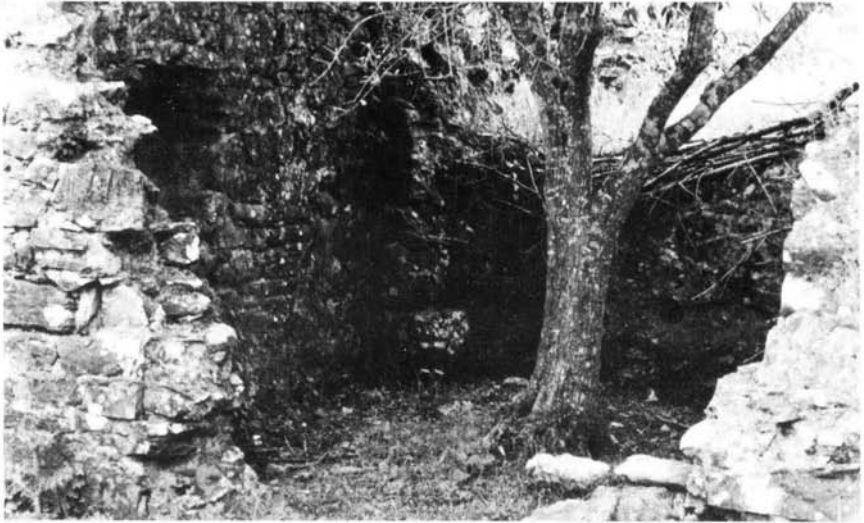
Fot. 107 — Tanque dos Mouros (Estremoz). Pormenor de um compartimento junto do canto sul, definido por dois contrafortes contíguos. Ao fundo, abertura para sair a água.
