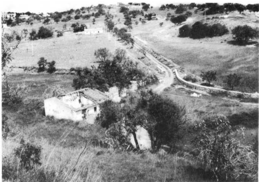
Fot. 61 — Barragem da Fonte Coberta (Lagos). Vista geral, de jusante.
