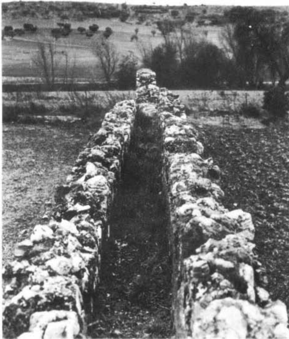
Fot. 124 — Aqueduto do Correio-Mor (Elvas). Pormenor do canal.
