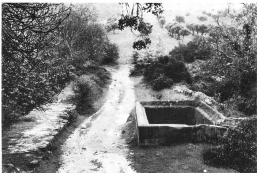
Fot. 87 — Barragem de Alferrarede (Abrantes). Vista do coroamento para a margem esquerda (tanque entre muros de construção recente).
