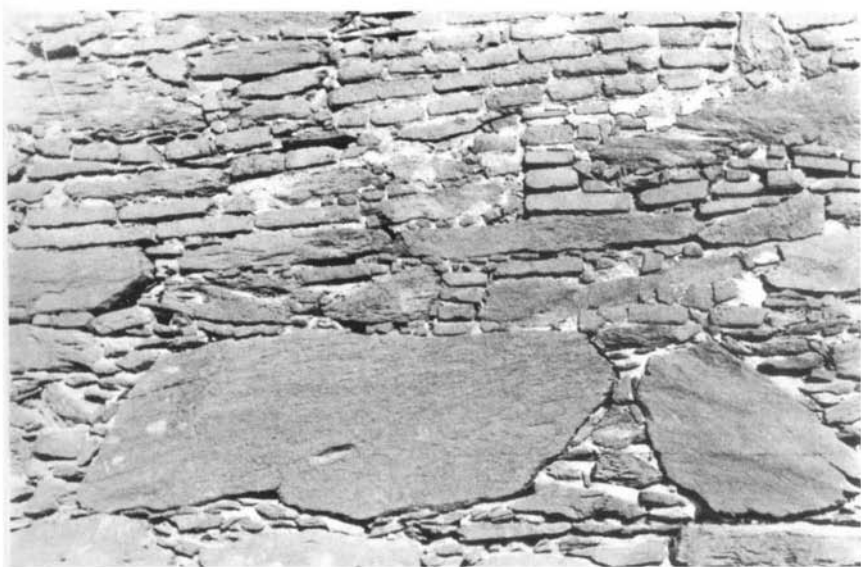
Fot. 73 — Barragem de Monte Novo (Évora). Pormenor do paramento de montante. Observam-se, na parte superior, tijolos correspondentes à reconstrução (fotografia da DGRAH).
