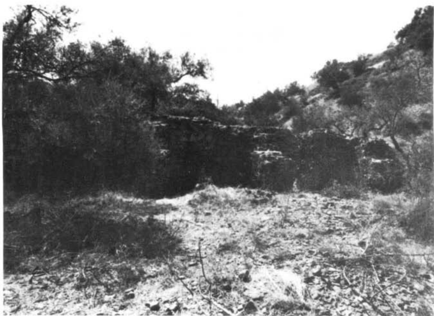
Fot. 53 — Barragem do Álamo (Alcoutim). Vista de jusante.
