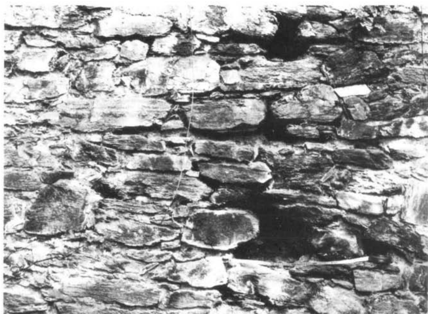
Fot. 88 — Barragem de Alferrarede (Abrantes). Pormenor do paramento de jusante
