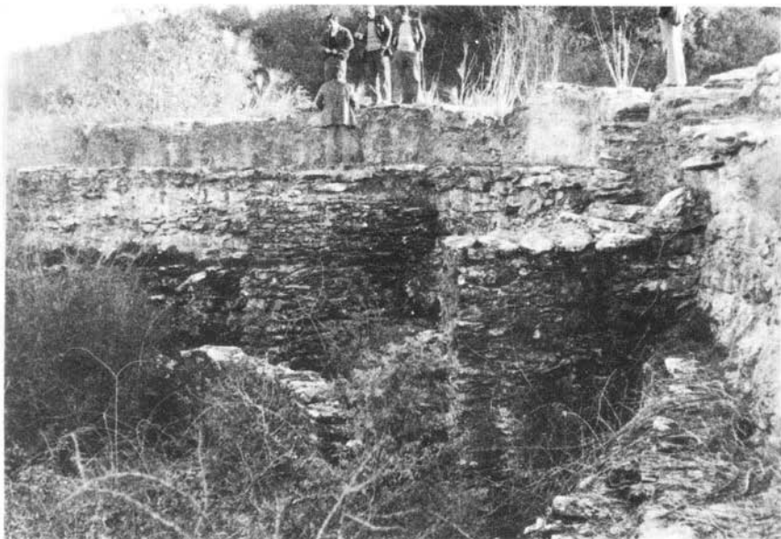
Fot. 71 — Barragem de Monte Novo (Évora). Vista de jusante, observando-se vários degraus e os dois contrafortes (fotografia da DGRAH).
