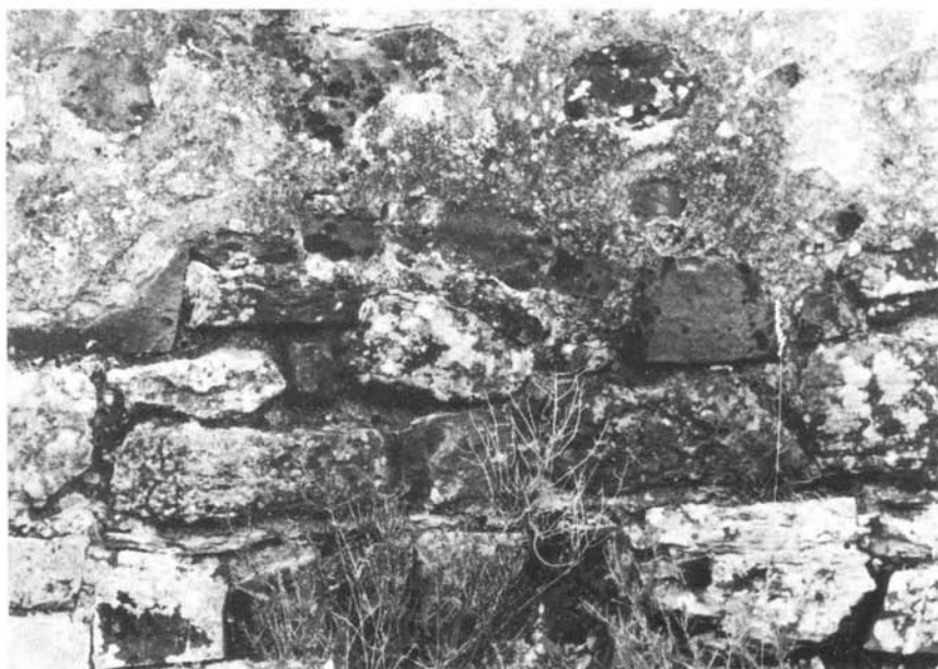
Fot. 60 — Barragem de Santa Rita (Vila Real de Santo António). Pormenor do paramento de montante, com revestimento de argamassa.
