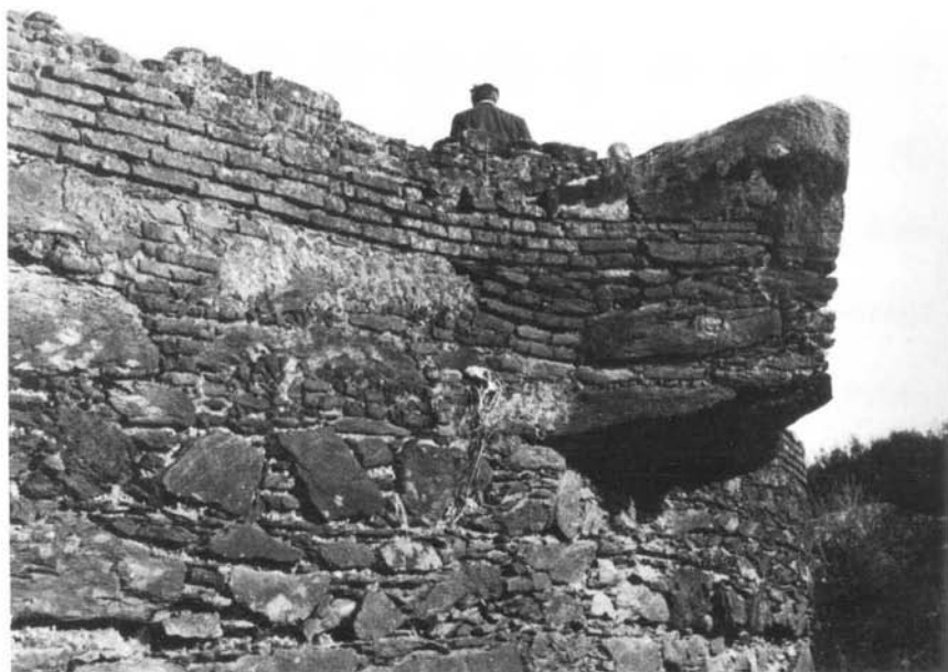
Fot. 76 — Barragem de Monte Novo (Évora). Parapeito no coroamento, a montante. (fotografia da DGRAH).
