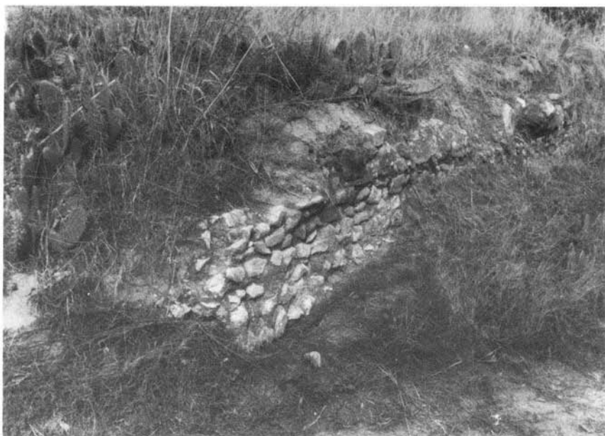
Fot. 125 — Aqueduto de Alcácer do Sal. Aspecto do aparelho construtivo.
