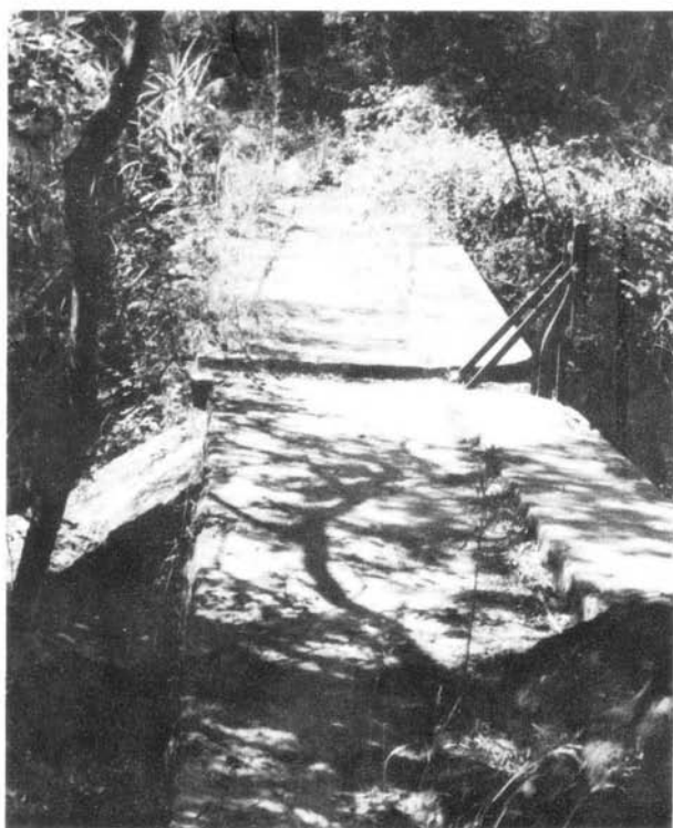
Fot. 26 — Barragem da Comenda (Setúbal). Aspecto do coroamento.
