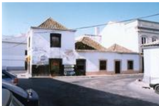
Fig. 40: Edifício Quinhentista na Rua Alexandre Herculano, em Faro, com coberturas em telhado de “tesouro”, do séc. XVII, em Vias de Classificação pelo Ministério da Cultura, in: http://radix.culturalg.pt/listar.html?tabela=5
