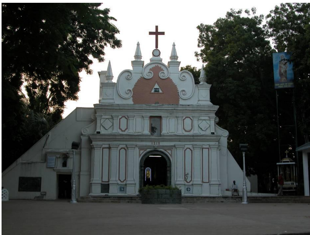
Figura 35: Igreja de Nossa Senhora da Luz, construída nas primeiras décadas de 1500 (a data que figura no alçado, 1516, oferece dúvidas não sendo no entanto posterior a 1530). O tratamento da fachada revela a plasticidade das argamassas tradicionais. Os contrafortes laterais, revelam o sistema construtivo ainda utilizado no séc. XVI para travamento das paredes dos salões com grandes vãos. Foto e observações do autor, 2009.
