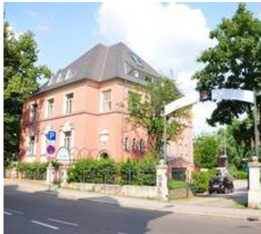
Figura 3.5. Edifício comercial, avenida Erich-Zeigner-Allee
