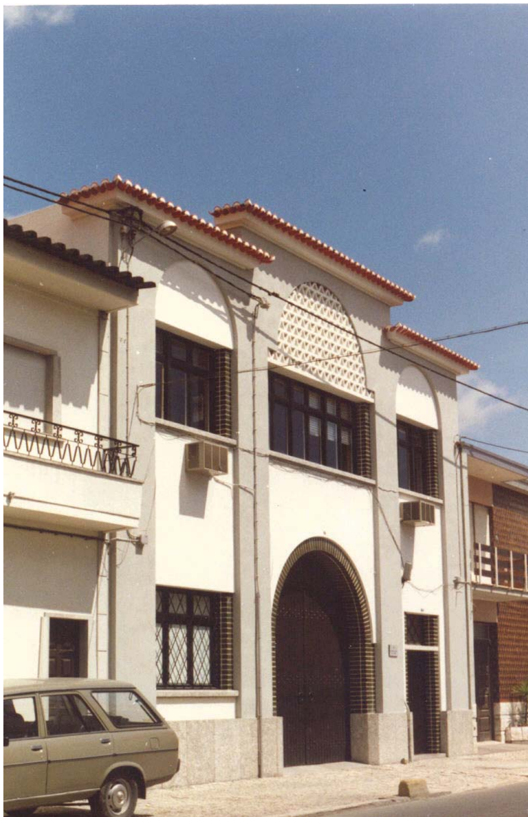
Edifício onde funcionavam os serviços administrativos Rua de Coruche – Almeirim
