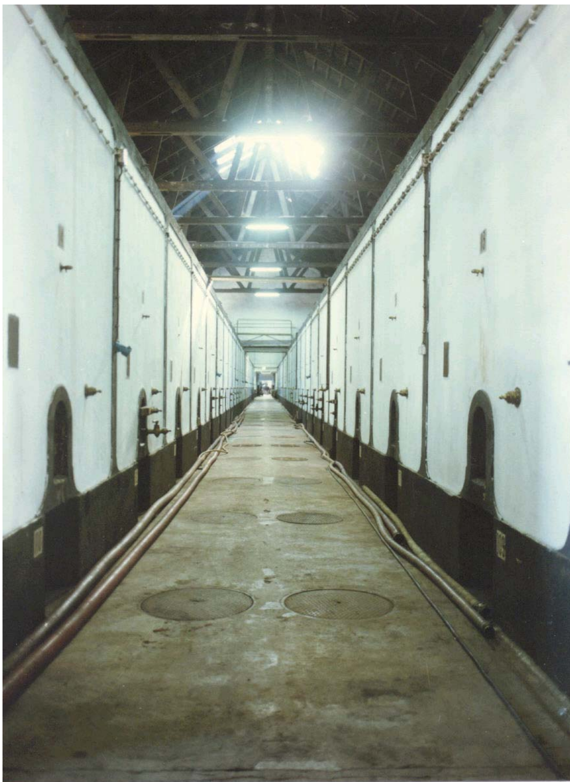
Armazém - Ala dos Depósitos (estrutura comum a vários armazéns)
