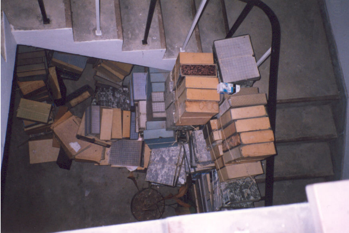
Fig. 1: Santarém: vão de escadas (1999)
