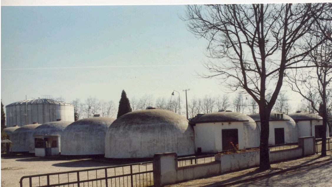
Depósitos em inox e tipo airform
