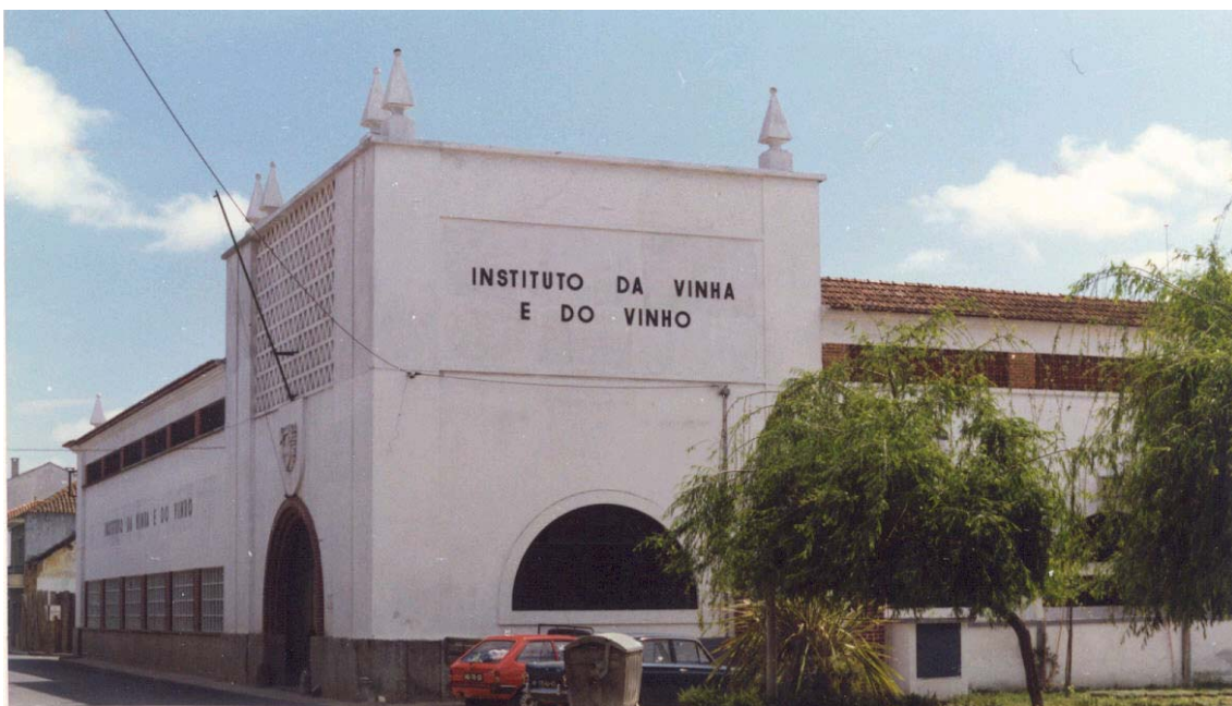
Rua de Coruche - Almeirim (Instalações onde foi previsto funcionar o Centro Histórico Vitivinícola Nacional)
