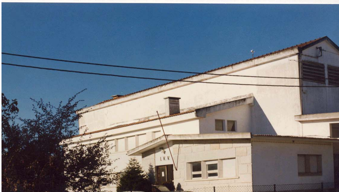
Armazéns de Moimenta da Beira
