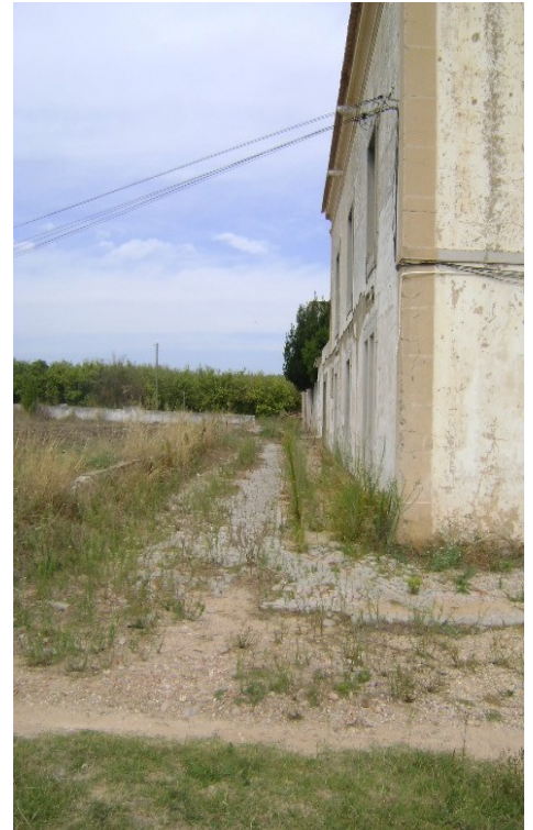
Antigo Edifício do Posto Agrário (Museu Municipal de Tavira)
