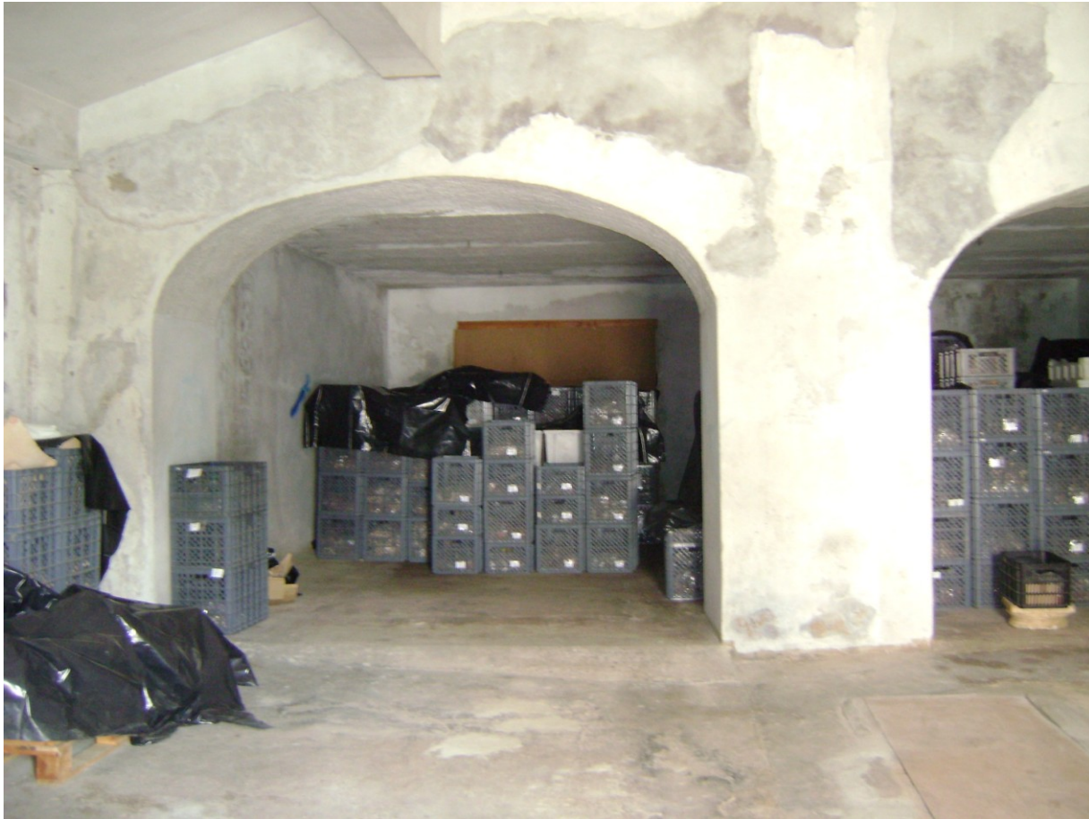
Figura: 2.9 – Interior do depósito
