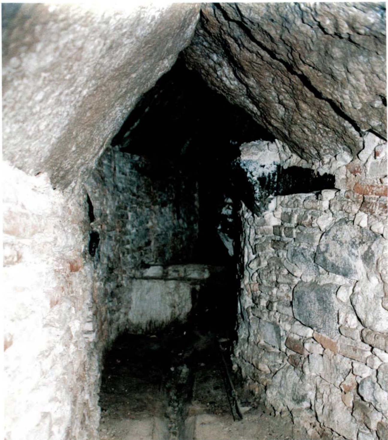
Fot. 12 - Galeria de mina de captação de água, próxima da Fábrica de Cima, com a abóbada em V invertido, de lajes calcárias, paredes de alvenaria e soleira percorrida por caleira central.
