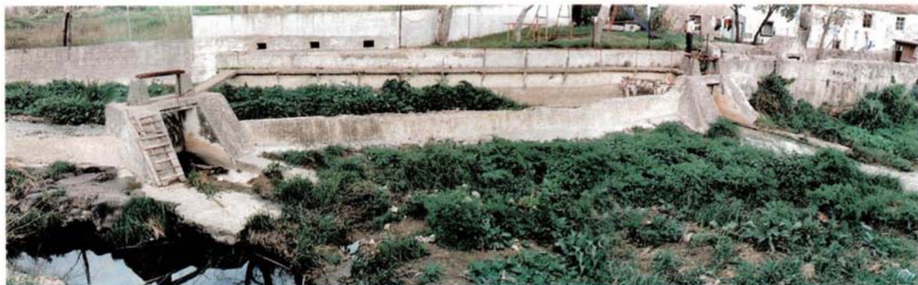
Fot. 14 - Vista geral do açude de derivação mostrando duas descargas, munidas de comportas montadas em estruturas de betão. Trata-se de alterações ao açude original.
