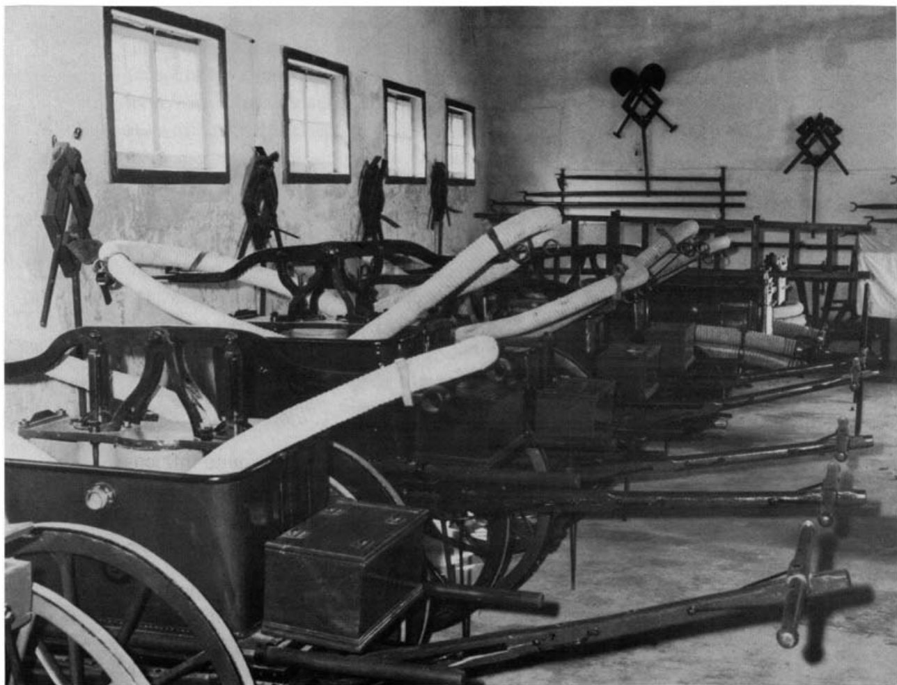
Fot. 9 - Interior do edifício com carros de bombeiros, de tracção e bombagem manual (fotografia antiga).
