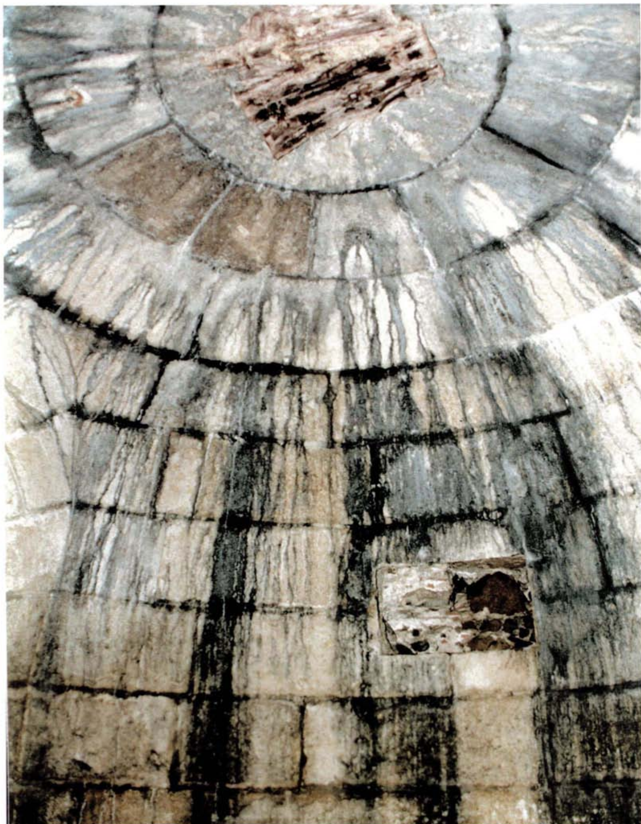
Fot. 17 - Fábrica de Cima . Câmara em abóbada, de cantaria de boa qualidade, para o sistema de transmissão do movimento ao engenho de galgas. A abertura no fecho da abóbada, para a passagem do veio vertical dos engenhos, encontra-se obturada.
