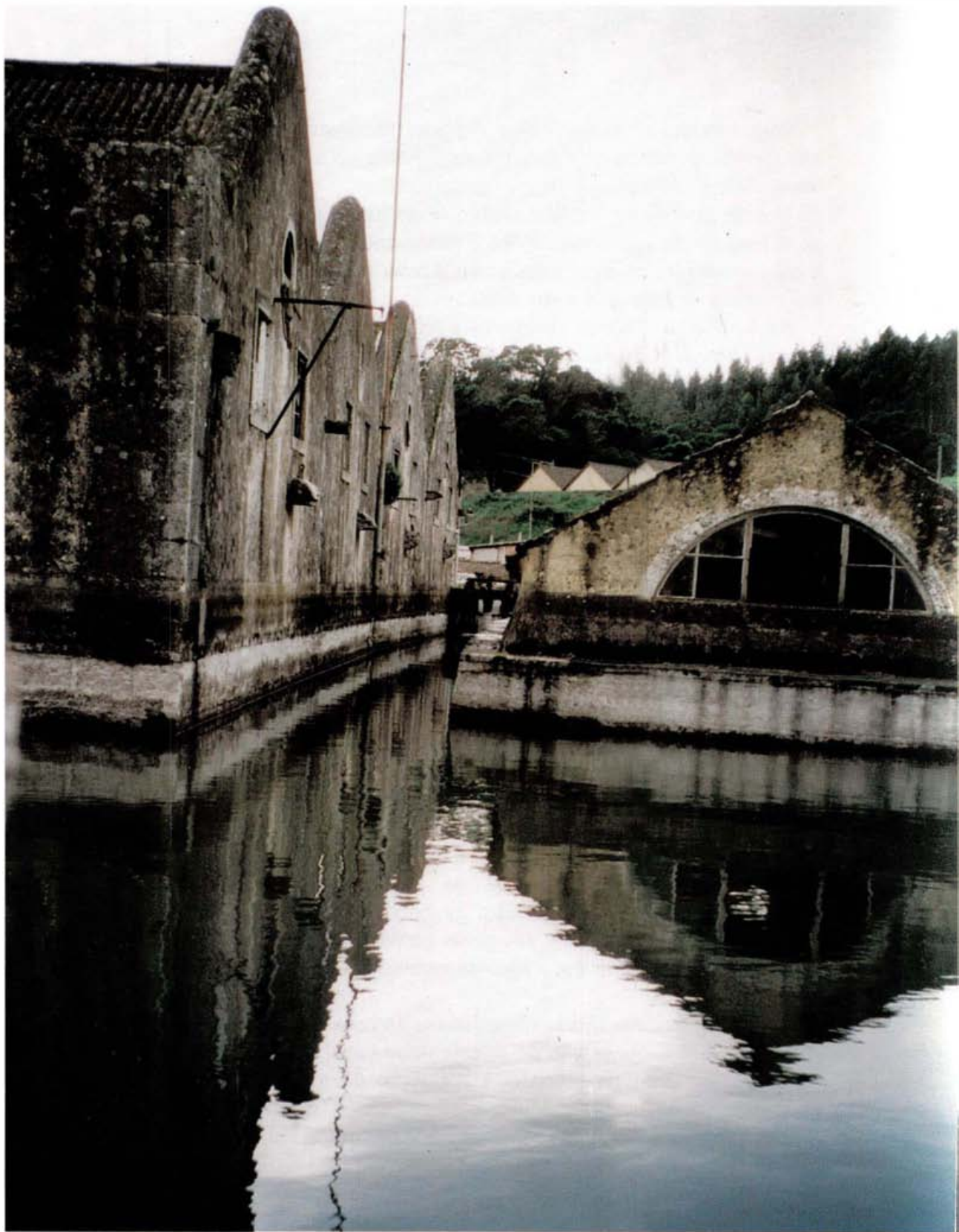
Fot. 15 - Fábrica de Cima, caldeira e canal de alimentação das azenhas, separando o edifício dos engenhos, à esquerda, do das oficinas, à direita.
