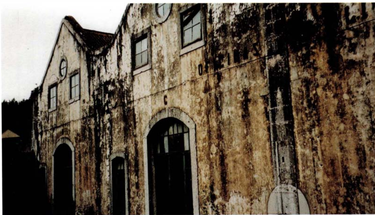
Fot. 16 - Fábrica de Cima. Alçada principal. Evidencia construção mais simples do que a correspondente à Fábrica de Baixo. Ver Fig. 25.
