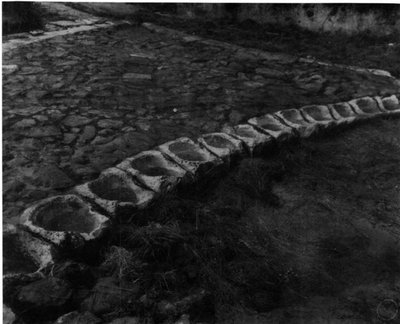
Fot. 2 - Vista geral dos almofarizes da antiga fábrica de engenhos de pilões, posteriormente aproveitados para a soleira de protecção do leito da ribeira de Barcarena a jusante do açude de derivação para a Fábrica (fotografia antiga).
