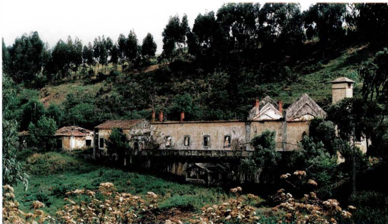
Fot. 1 - Fábrica de Barcarena. Edifícios para armazenamento e refinação do salitre.
