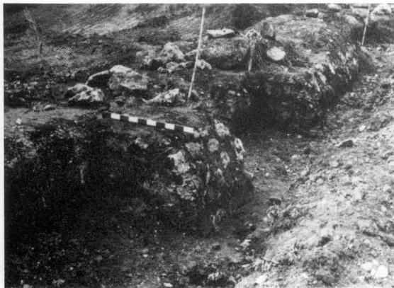
Fot. 8 - Barragem do Vale Tesnado. Contrafortes de montante, na zona central.
