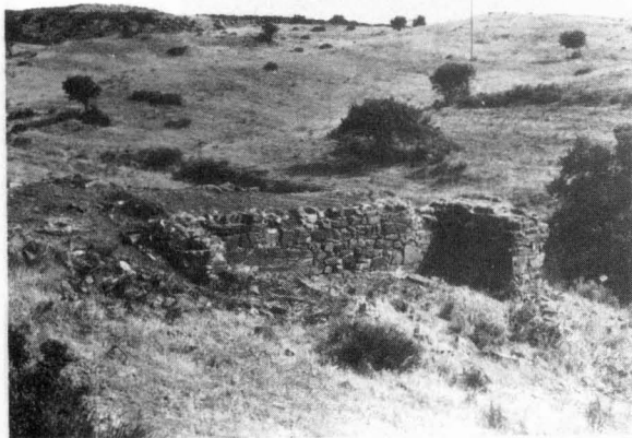
Fot. 3 - Barragam de Santa Rita. Vista de jusante, da margem direita.
