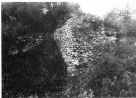
Fot. 11 - Barragem da Ponte dos Mouros. Vista a partir da margem esquerda, notando-se o muro e o contraforte a jusante.
