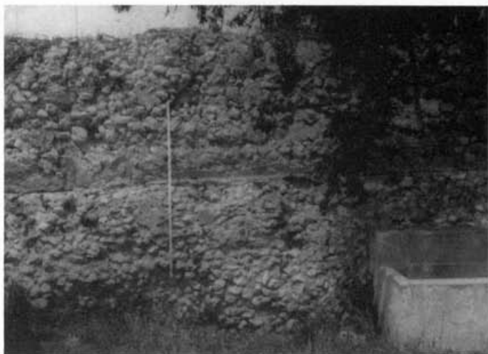
Fot. 4 - Barragem da Fonte Coberta. Vista de jusante.
