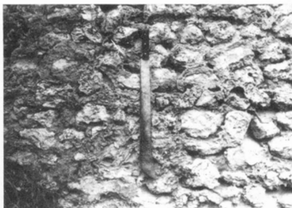
Fot. 13 - Barragem da Ponte dos Mouros. Pormenor do paramento de jusante.
