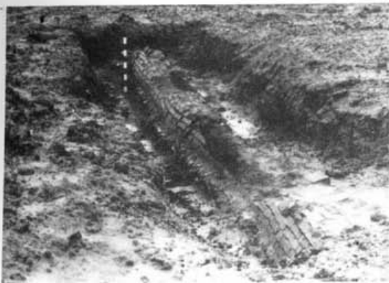
Fot. 9 - Barragem do Vale Tesnado. Troço coberto do canal do Cerro da Vila.
