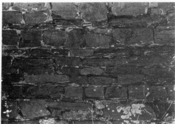
Fot. 2 - Barragem do Álamo. Pormenor do paramento de jusante.
