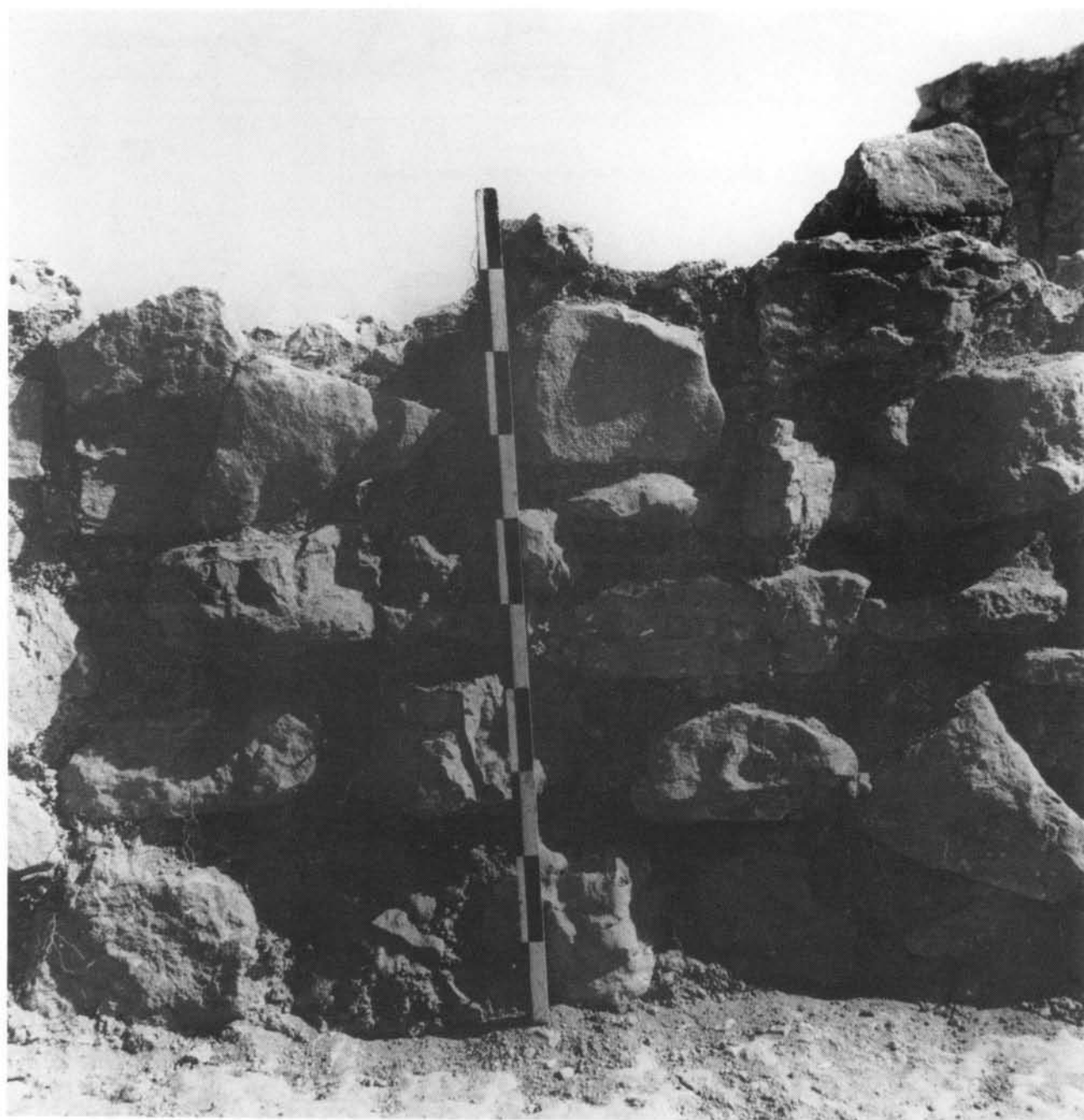
Fig. 36. Pormenor do aparelho construtivo do paramento interno do Bastião G.
