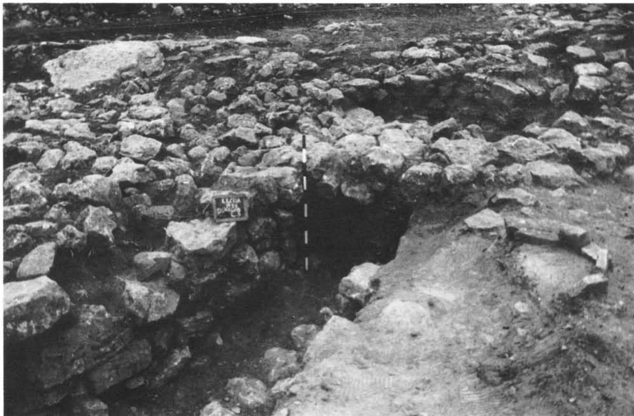
Fig. 78. Ao centro da fotografia, pormenor que evidencia a menor antiguidade da Casa HH, face ao Reforço GG2, pela diferença de cotas de fundação respectivas.
