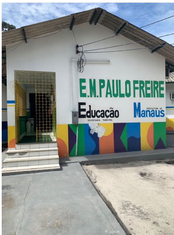
Figura 34: Escola municipal na Comunidade Agrovila
