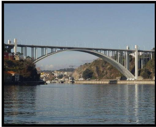
Figura 6.29 – Ponte da Arrábida no Porto-PT.
