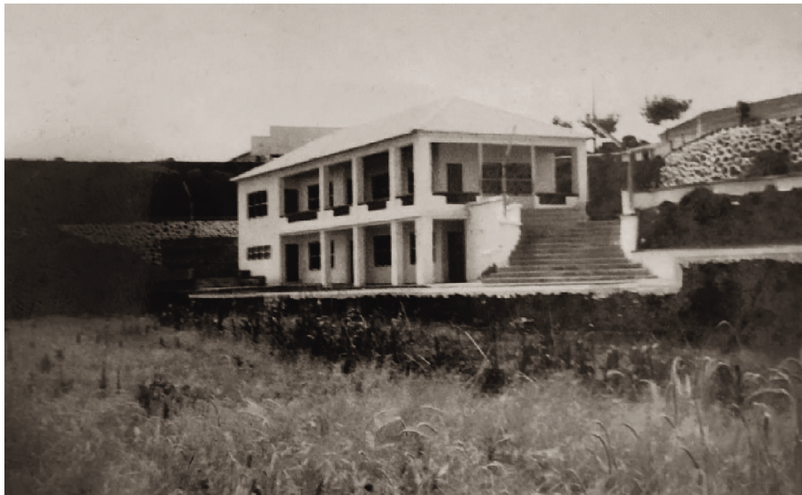
Edifício do Externato da Madalena (fase inicial, 1972)
