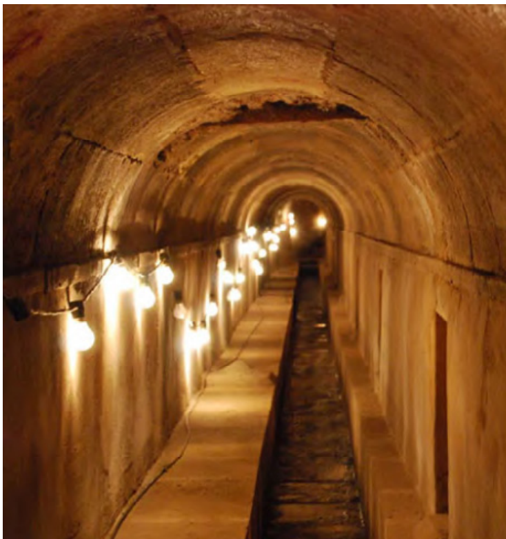
Figura 22 - Interior da Galeria das Necessidades. P. Inácio|MDA|EPAL, 2012.
