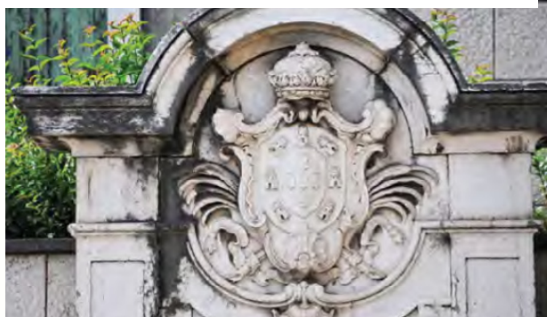
Figura 56 - Pormenor do Chafariz da Buraca. P. Inácio|MDA|EPAL, 2012.
