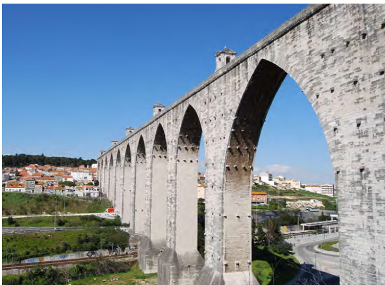
Figura 6 - Travessia do Vale de Alcântara. MDA|EPAL, 2012.
