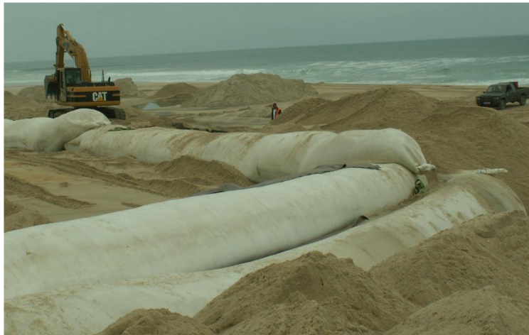
Figura 14 - Instalação de geotubos na praia de Leirosa (Figueira da Foz, Portugal) em 2008 (Antunes do Carmo, 2013).
