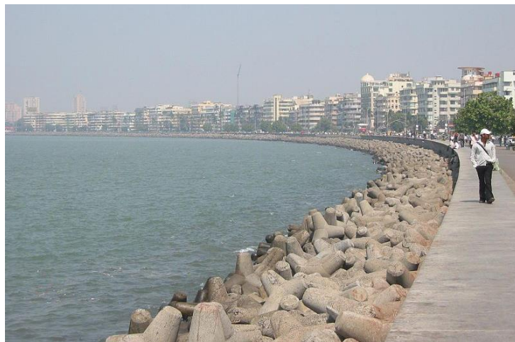
Figura 8 – Paredão construído com tetrápodes de betão em Mumbai, Índia. Fonte: Kelisi – CC-BY-SA/3.0 – https://commons.wikimedia.org/w/index.php?curid=19742084 .
