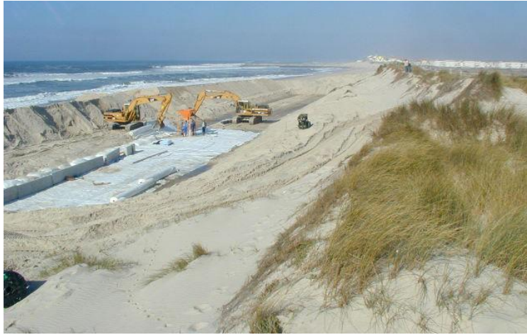
Figura 13 - Instalação de geocontentores na praia de Leirosa (Figueira da Foz, Portugal) em 2005 (Antunes do Carmo, 2013).
