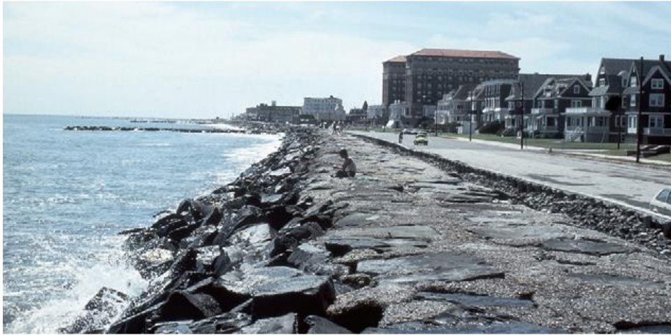
Figura 7 – Paredão construído com blocos de rocha (enrocamento) em Cape May (Nova Jérсия, EUA) (Bush et al. , 2001).
