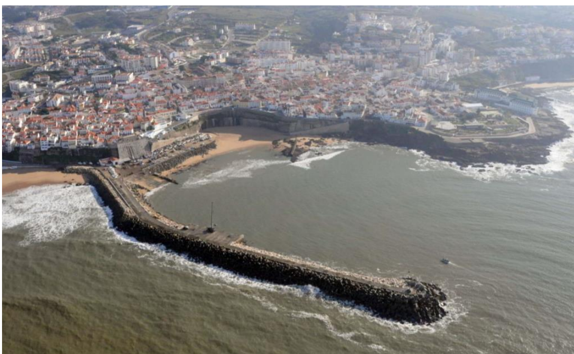
Figura 6 – Quebra-mar ancorado do Porto da Ericeira (Lisboa, Portugal) (APA, 2017).
